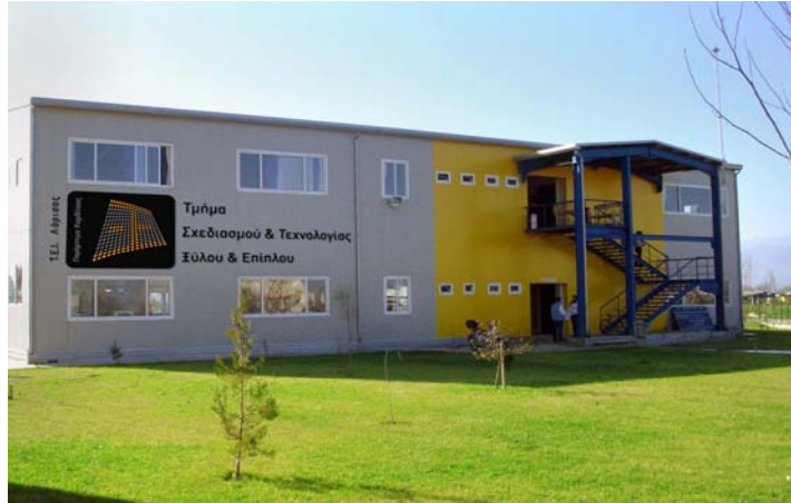
Το κτίριο εργαστηρίων του Τμήματος στο Παράρτημα Καρδίτσας
