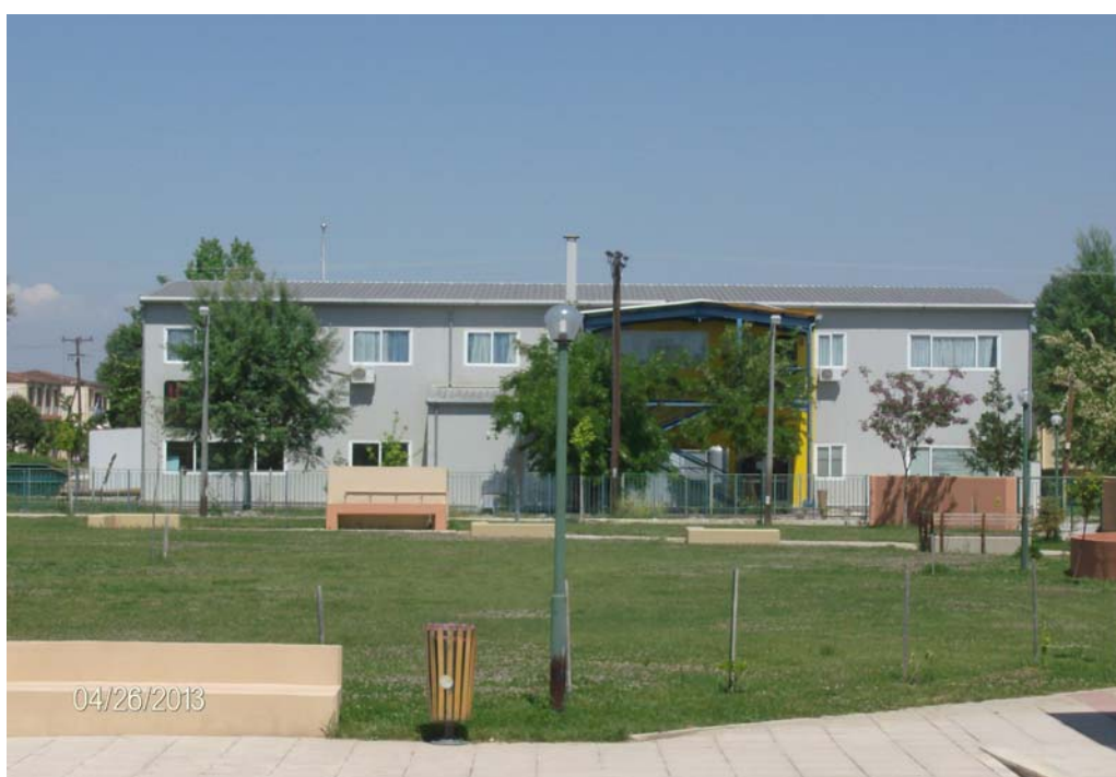
Το κτίριο εργαστηρίων του Τμήματος Σχεδιασμού και Τεχνολογίας Ξύλου και Επίπλου http://www.wfdt.teilar.gr/cd.php
