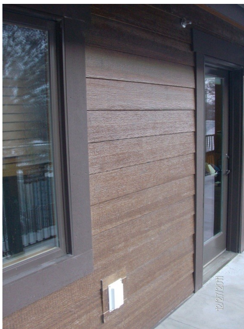
Επένδυση σε wooden-framed εξοχική κατοικία, από νέο προϊόν WPC σε απομίμηση «νερών» ξύλου ( Glenwood Springs, Colorado, 27/12/2011 ), θερμοκρασία -13^{\circ}\text{C}
