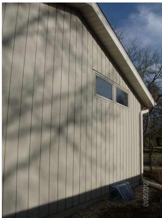
Ξυλεπένδυση ( siding ) σε wooden-framed ξύλινο σπίτι, από το ανθεκτικό είδος Western red cedar , επαρκώς φινιρισμένη ( Madison, Wisconsin, 5/1/2012 )
