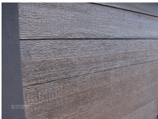
Επένδυση σε wooden-framed εξοχική κατοικία, από νέο προϊόν WPC σε απομίμηση «νερών» ξύλου ( Glenwood Springs, Colorado, 27/12/2011 ), θερμοκρασία -13^{\circ}\text{C}
