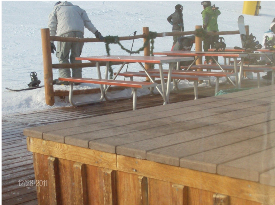
Χρήση προϊόντος wood plastic composite (WPC) σε εξωτερικό δάπεδο deck (χρήση σε υψόμετρο 2.000 m με ακραίες καιρικές συνθήκες, χιονοδρομικό κέντρο)
