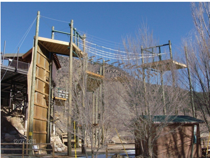
Ξύλινες δομικές κατασκευές, σε χώρους αναψυχής, εμποτισμένες με άλατα CCA (σημ. η ξυλεία που κυριαρχεί στα εμποτισμένα προϊόντα είναι η Southern yellow pine αφού στις ΗΠΑ, το ~60% της στρογγυλής/πριστής ξυλείας του είδους αυτού εμποτίζεται· αποτελεί δε μια τεράστια αγορά αν υπολογισθούν τα εκατομμύρια m 3 που απαιτούνται κάθε χρόνο στις ΗΠΑ, κυρίως στα δίκτυα τηλεπικοινωνιών, ηλεκτρικής ενέργειας και σιδηροδρόμων κ.α.)
