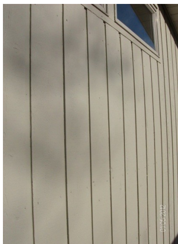
Ξυλεπένδυση ( siding ) σε wooden-framed ξύλινο σπίτι, από το ανθεκτικό είδος Western red cedar , επαρκώς φινιρισμένη ( Madison, Wisconsin, 5/1/2012 )
