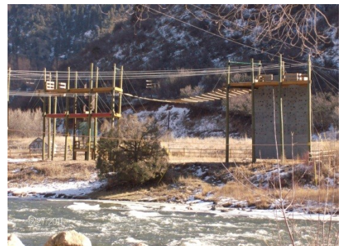
Ξύλινες δομικές κατασκευές, σε χώρους αναψυχής, εμποτισμένες με άλατα CCA (σημ. η ξυλεία που κυριαρχεί στα εμποτισμένα προϊόντα είναι η Southern yellow pine αφού στις ΗΠΑ, το ~60% της στρογγυλής/πριστής ξυλείας του είδους αυτού εμποτίζεται· αποτελεί δε μια τεράστια αγορά αν υπολογισθούν τα εκατομμύρια m 3 που απαιτούνται κάθε χρόνο στις ΗΠΑ, κυρίως στα δίκτυα τηλεπικοινωνιών, ηλεκτρικής ενέργειας και σιδηροδρόμων κ.α.)
