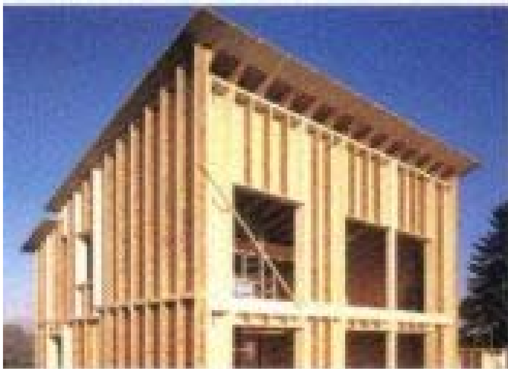
Εικόνα 10. Κατασκευή κατοικίας με χρήση LSL.
