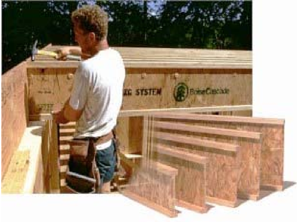
Εικόνα 18. Χρήση δοκών τύπου Ι στην κατασκευή σπιτιών
