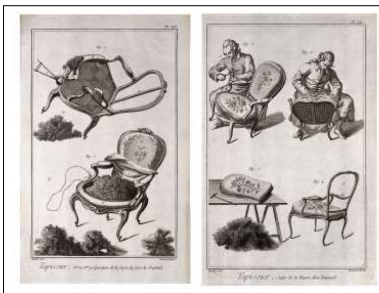
Εικ. 2. Εργασίες ταπετσαρίας σε πολυθρόνα. Γέμισμα με ζωικές ίνες, κατασκευή βάσης με πλέξιμο μάντων (18 ος αι.).
