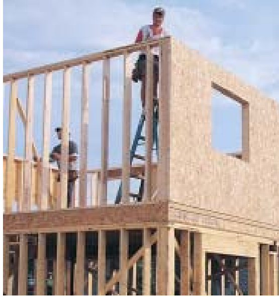
Πηγή: OSB Engineered to Perform for Housing and Construction. Εικ. 10. Επένδυση εξωτερικής τοιχοποιίας από OSB.
