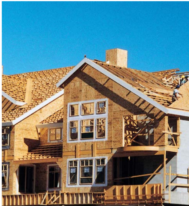
Εικ. 9. Επένδυση εξωτερικής τοιχοποιίας από OSB.
