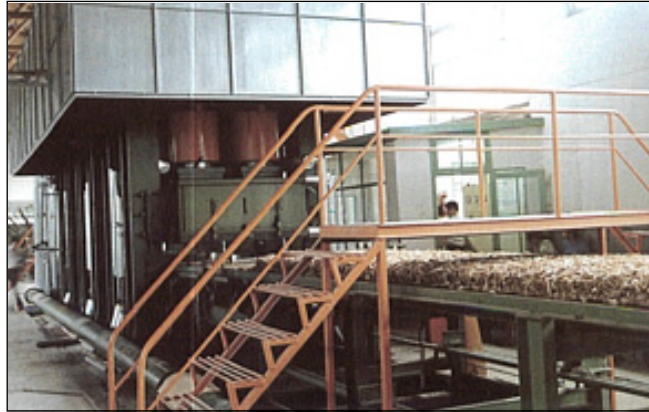
Εικ. 3. Στρωματωμένο υλικό λίγο πριν εισέλθει σε πρέσα συνεχούς τροφοδοσίας.
