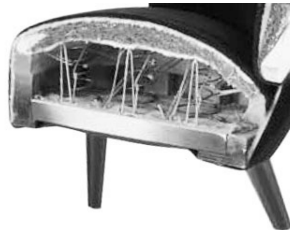
Εικόνα 16: Τομή πολυθρόνας του Tom Dixon για την εταιρεία George Smith (2009) φτιαγμένη με παραδοσιακά υλικά. Διακρίνονται οι σούστες, το ξύλινο πλαίσιο κάτω, το δέσιμο με σχοινί επάνω, και τα υπόλοιπα υλικά που μπαίνουν από επάνω όπως βαμβακερό ύφασμα, γέμιση από στρώσεις γουρουνότριχας (boar bristle) και βαμβακιού, βαμβακερό ύφασμα και το τελικό ύφασμα!
