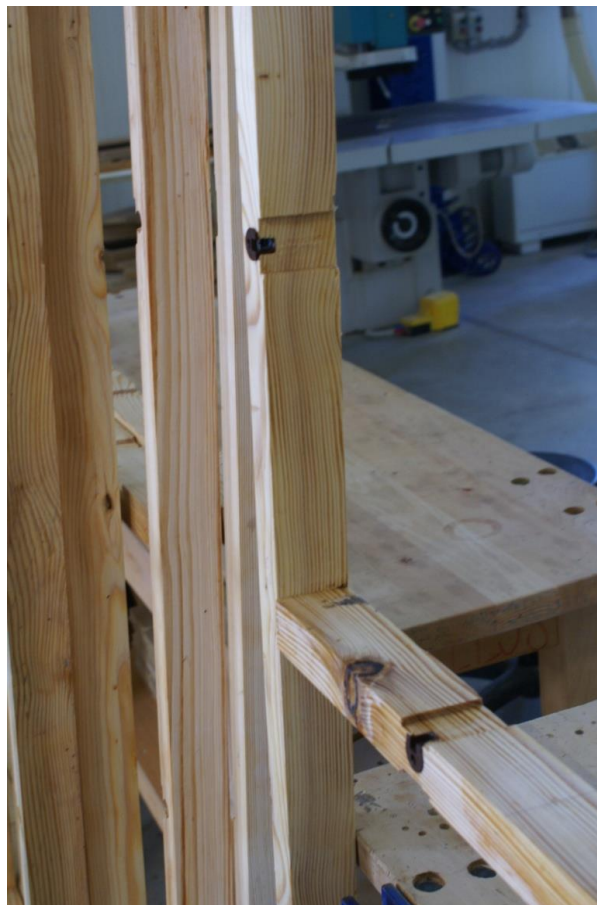
Εικόνα 139 Τοποθέτηση φυραμιών
