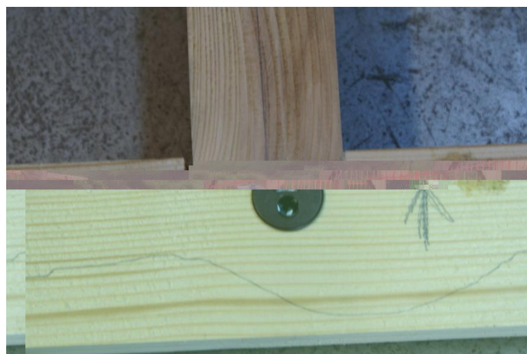
Εικόνα 77 Τοποθέτηση φυραμιών
