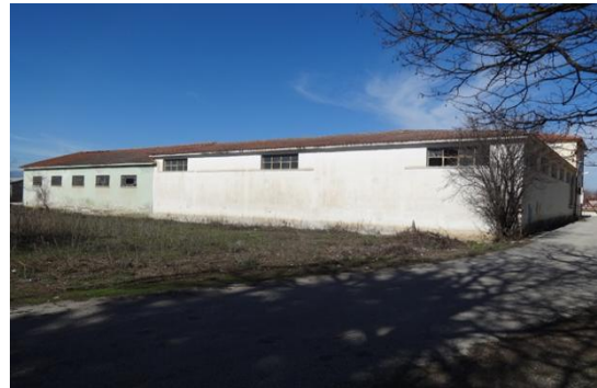
Εικόνα 281: Πίσω όψη κτιρίου αποθήκης της Ένωσης Αγροτικών Συνεταιρισμών στην περιοχή Καρδιτσομαγούλας, (Ανθούλα Καραμούζη, 2014)
