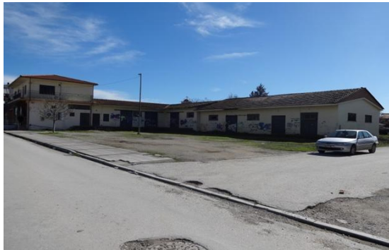
Εικόνα 280: Μπροστινή όψη κτιρίου αποθήκης της Ένωσης Αγροτικών Συνεταιρισμών στην περιοχή Καρδιτσομαγούλας, (Ανθούλα Καραμούζη, 2014)
