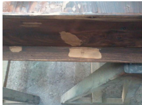
Εικόνα 70 Εμφάνιση στόκων στο πλαϊνό μέρος της επιφάνειας
