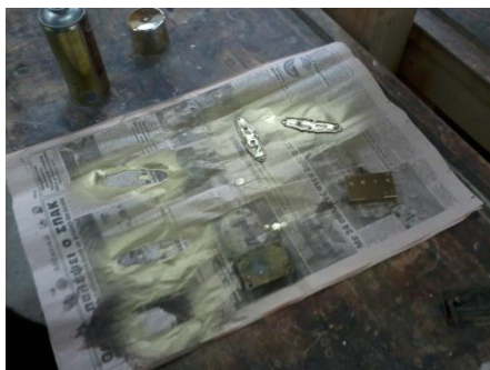
Εικόνα 82 Βάψιμο μεταλλικών στοιχείων
