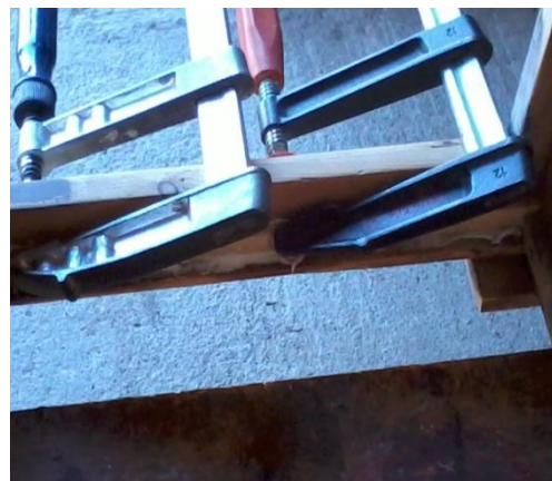
Εικόνα 63 Επιδιόρθωση τμήματος πλαϊνού
