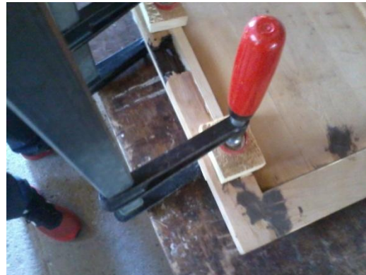
Εικόνα 73 Αντικατάσταση σαπισμένου τμήματος στο πορτάκι
