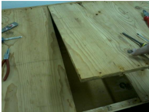
Εικόνα 67 Επίσκευή πάτου επιφάνειας γραφείου
