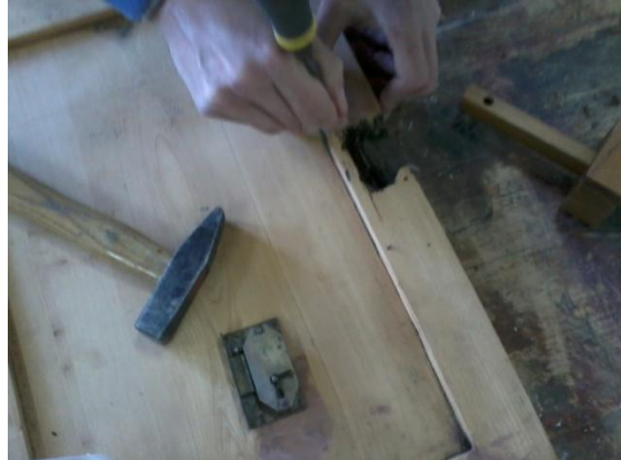
Εικόνα 61 Επισκευή σαπισμένου τμήματος
