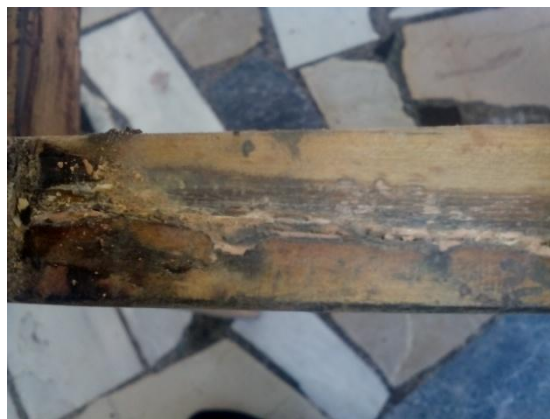
Εικόνα 97 Αφαίρεση παλιού στόκου
