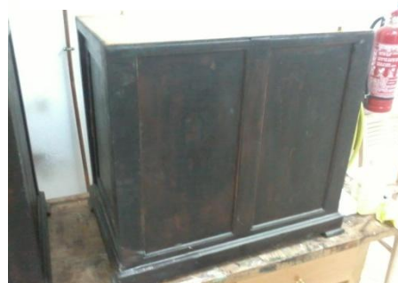
Εικόνα 42 Εμφανής διαφορά είδους ξύλου ως μπάλωμα στο πλαϊνό
