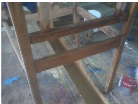
Εικόνα 92 Εφαρμογή μυκητοκτόνου-εντομοκτόνου
