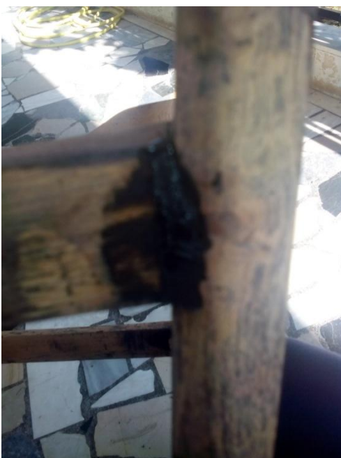
Εικόνα 99 Στοκάρισμα σύνδεσης τραβέρσας-ποδιού
