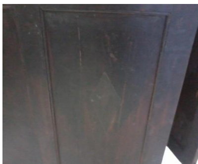
Εικόνα 43 Διαφορά χρώματος στις επιφάνειες
