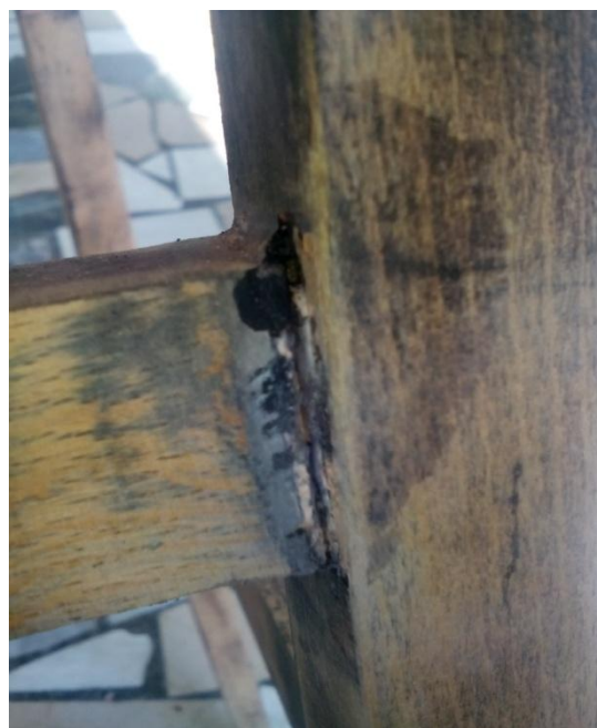
Εικόνα 100 Αφαίρεση προηγούμενου στόκου στη σύνδεση τραβέρσας-ποδιού
