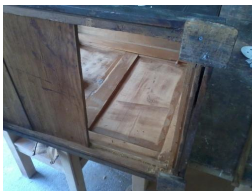
Εικόνα 57 Ξεμοντάρισμα πάτου πλαϊνού στοιχείου
