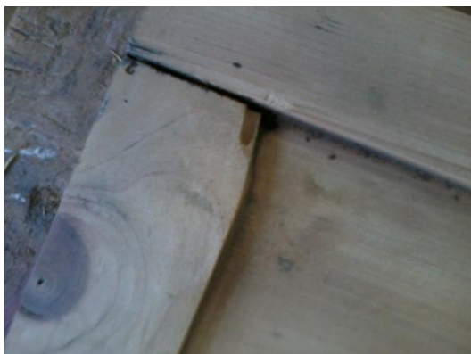
Εικόνα 65 Ανάγκη στοκαρίσματος στο πορτάκι
