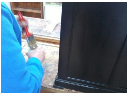
Εικόνα 77 Εφαρμογή γομαλάκας στο πλαϊνό
