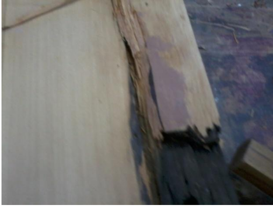
Εικόνα 62 Σάπισμα τμήματος από το πορτάκι
