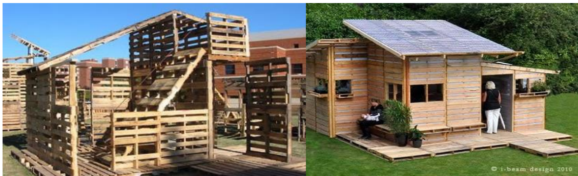
Εικόνα 19: Χρήση παλέτας σε οικοδομική κατασκευή ( www.virálnova.com )
