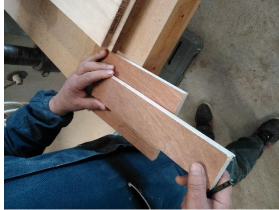
Εικόνα 119. Κατασκευή μπροστινού τμήματος.
