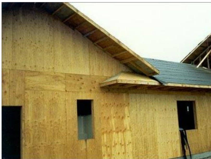
Εικόνα 13. Κάλυψη μεγάλης εξωτερικής επιφάνειας από αντικολλητό.
