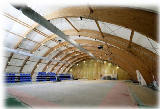
Εικόνα 12 Μασίφ επικολλητή ξυλεία ως φέρον στοιχείο στο εσωτερικό γηπέδου
