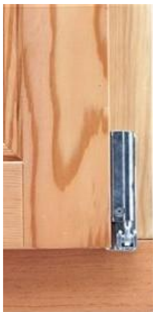
Εικ. 82. Κάτω μεντεσές κάσας.
