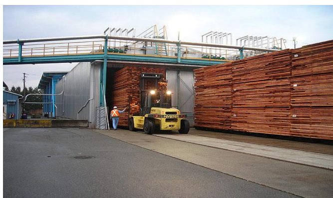
Εικ. 10. Θάλαμος τεχνητής ξήρανσης
