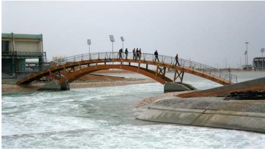
Εικ. 31. Γέφυρα από επικολλητό ξύλο.
