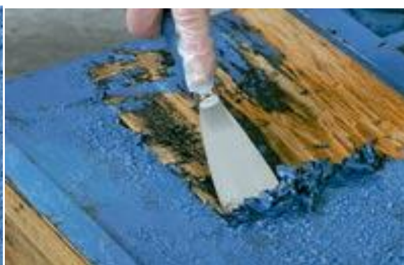
Εικόνα 2.5 Απομάκρυνση μπογιάς με σπάτουλα
