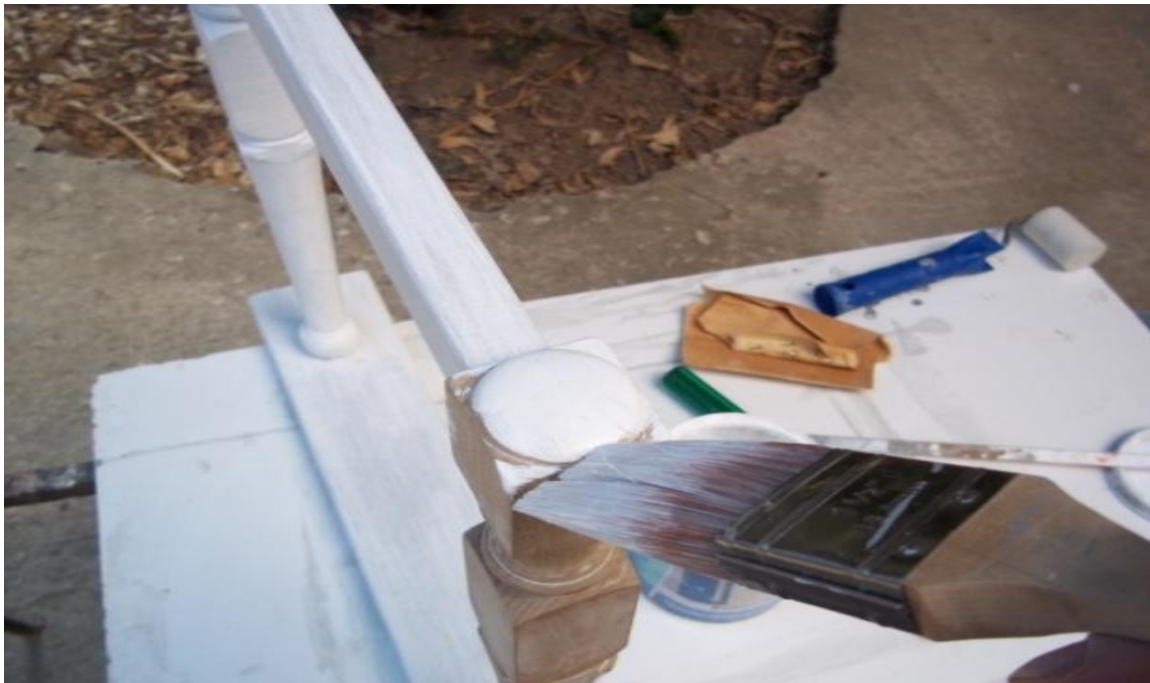
Εικόνα 3.30 Βάψιμο με ριπολίνη νερού (1 ο πέρασμα)
