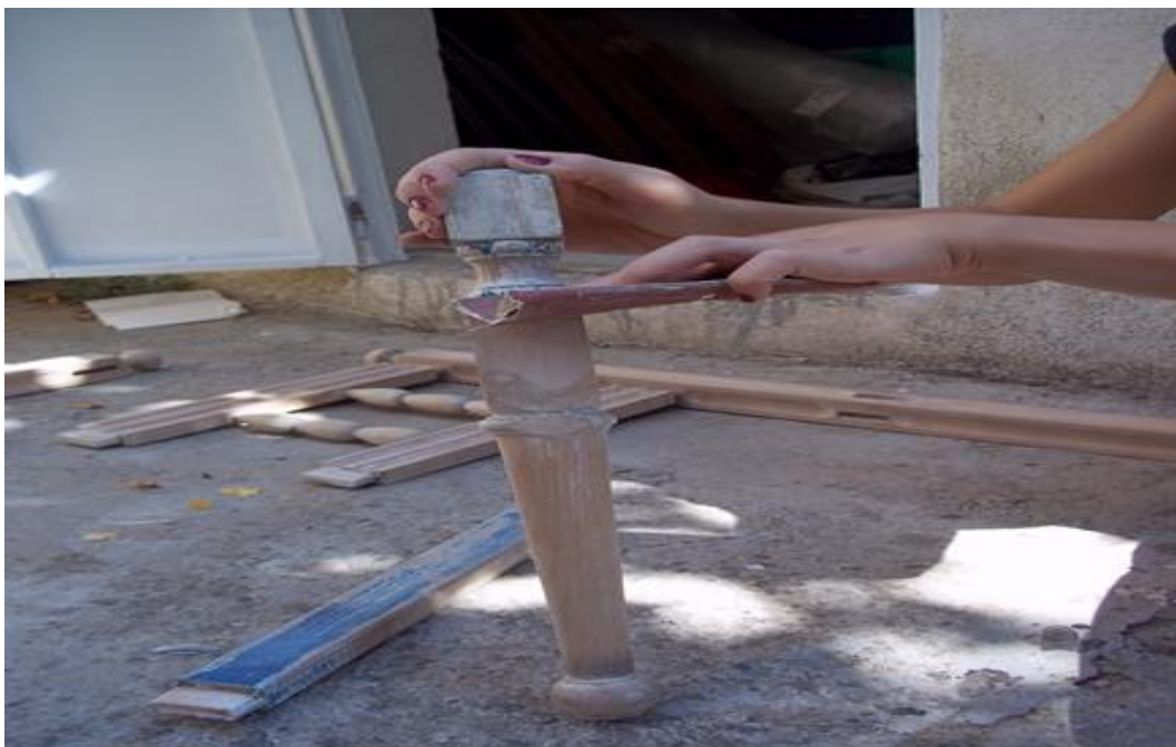
Εικόνα 3.10 Υπολείμματα χρώματος που απέμειναν και επιφανειακή υγρασία, τρίφτηκαν με Γυαλόχαρτο Νο. 120
