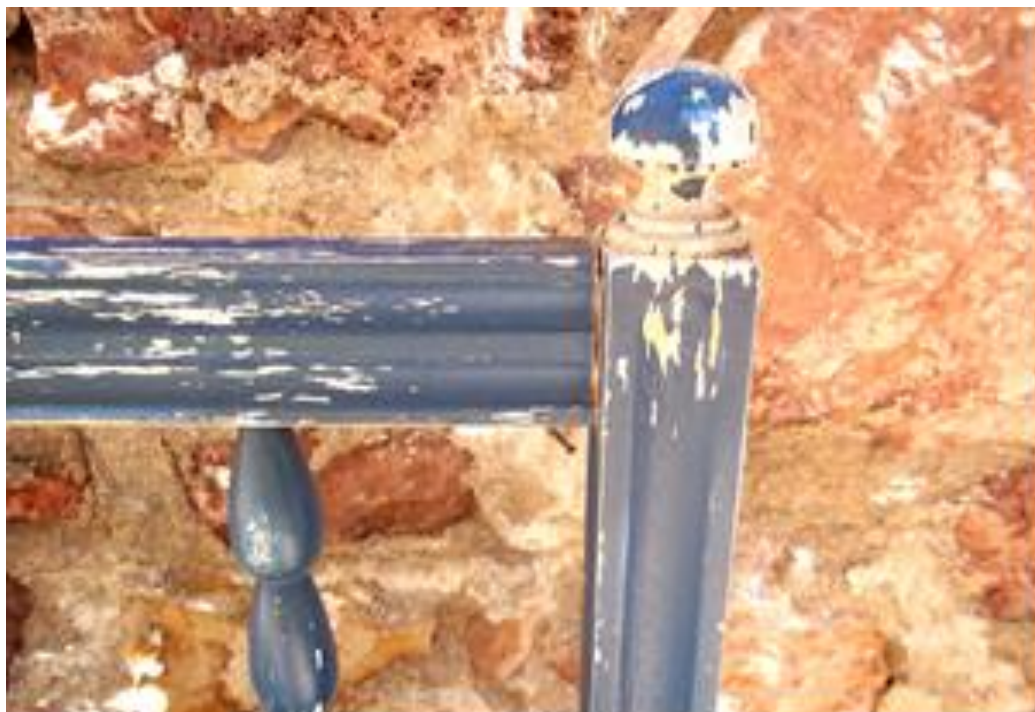
Εικόνα 3.4 Πολλές από τις συνδέσεις έχουν χαλαρώσει και αποκολληθεί
