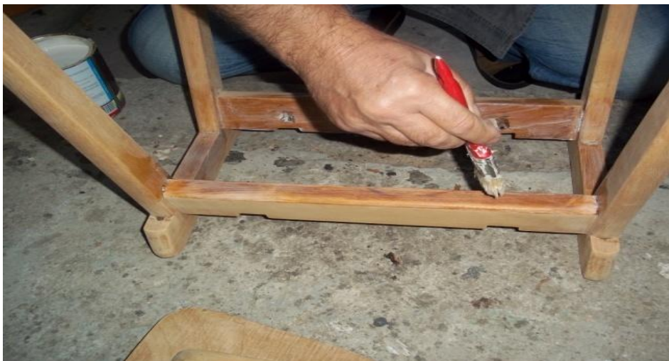
Εικόνα 3.52 Επάλειψη με αστάρι
