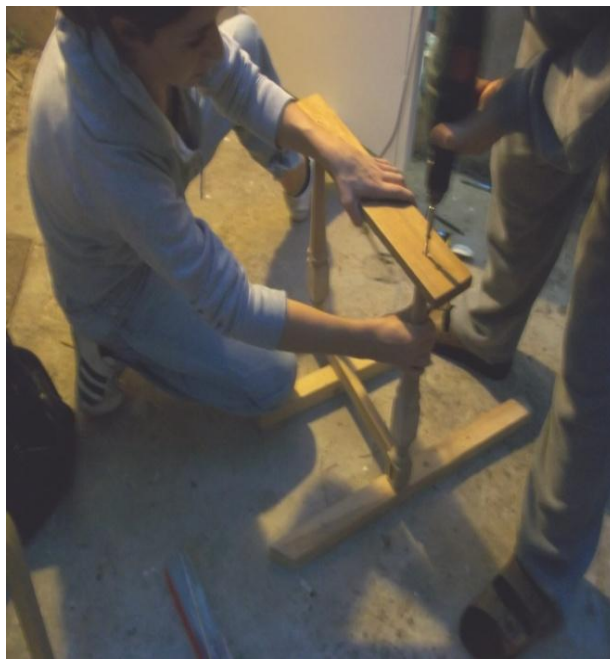
Εικόνα 3.28 Σύνδεση βάσης με τα πόδια
