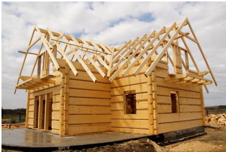
Εικόνα 3. Χρήση ξύλου για δομικές κατασκευές
