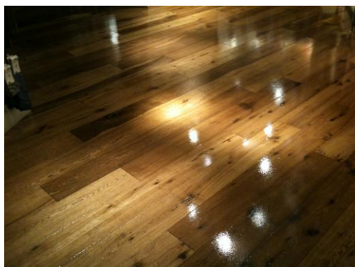
Αποτέλεσμα φινιρίσματος με κερί..
