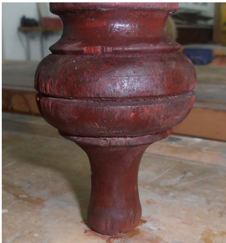
Εικ. 15.3.8: Πόδι του γραφείου μετά την αισθητική αποκατάσταση
