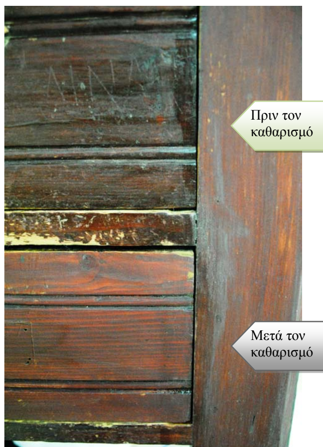
Εικ. 13.2.2: Διαφορά πριν και μετά το πέρασμα μίγματος white spirit και αλκοόλης (αφαίρεση παλιού βερνικιού)
