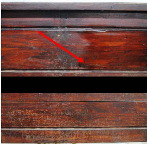
Εικ. 13.3.1: Τα ίχνη από το χνούδι που άφηνε το πανί κατά το πέρασμα του και η ένδειξη ότι υπάρχει στο σημείο ακόμα παλιό βερνίκι
