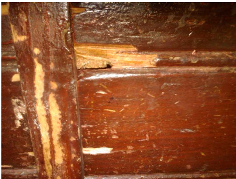
Εικ. 11.1.13: Βαθιές εκδορές και διαμπερή οπή σε τμήμα του επίπλου
