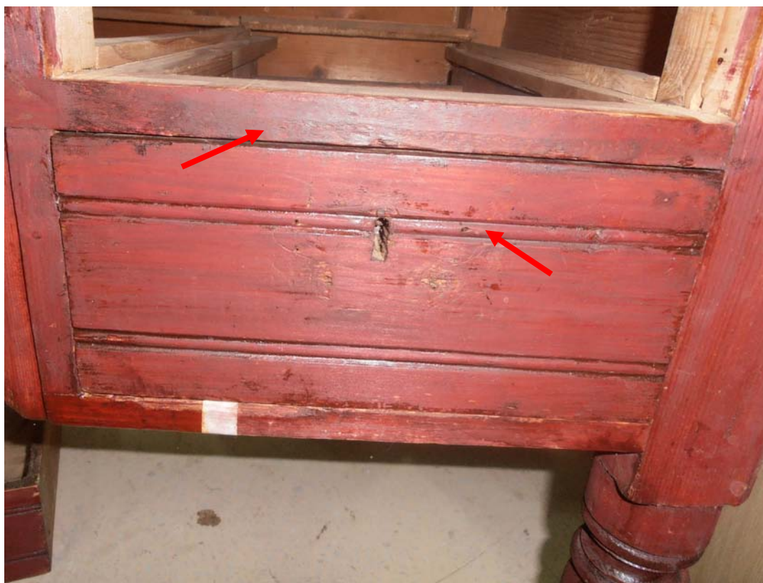
Εικ. 15.3.6: Σημείο αποκατεστημένο στην απόχρωση κάσας
