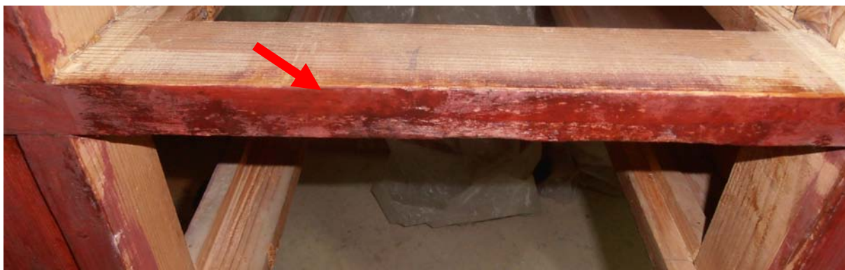
Εικ. 15.3.3: Σημείο αποκατεστημένο στην απόχρωση κάσας
