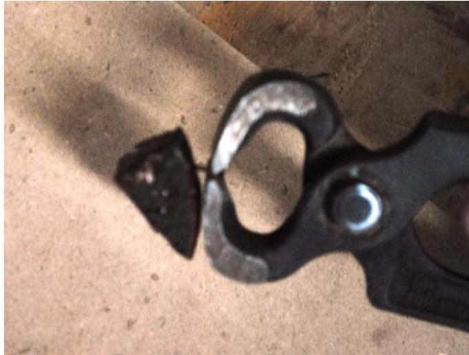
Εικ. 14.1.2: Αφαίρεση των καρφιών από το διακοσμητικό κομμάτι με τη βοήθεια εξωλκέα
