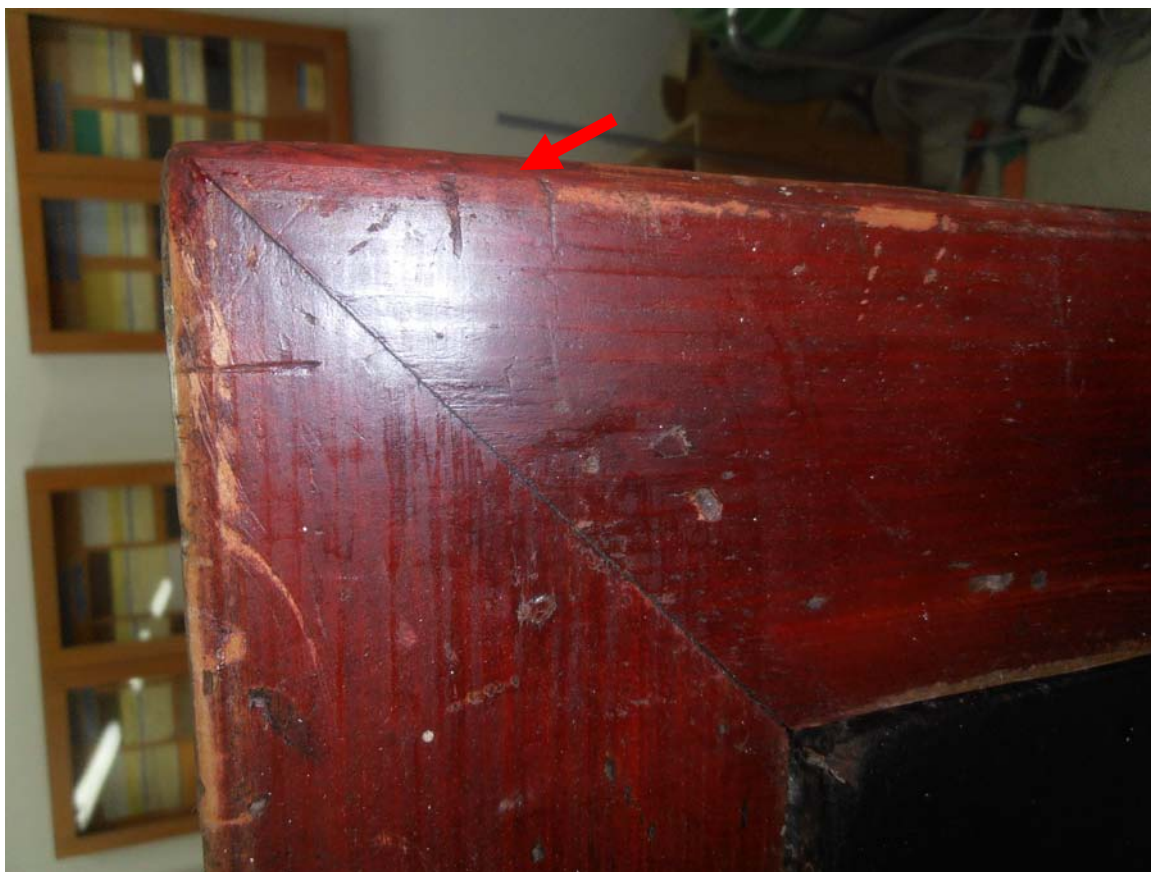
Εικ. 15.3.5: Σημείο αποκατεστημένο στην απόχρωση κάσας
