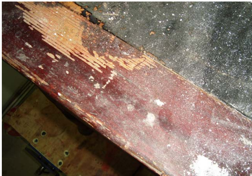
Εικ. 11.1.4: Λεπτομέρεια του καπακιού πριν την συντήρηση (εμφανείς εκδορές, βαθουλώματα και απώλειες)
