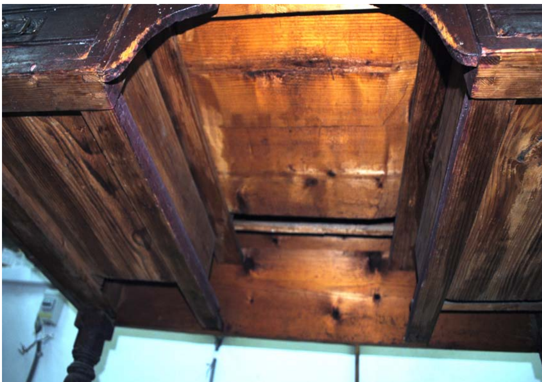
Εικ. 11.1.11: Η κάτω όψη του επίπλου (άβαφα μέρη) μετά την εφαρμογή White spirit, λεπτομέρεια
