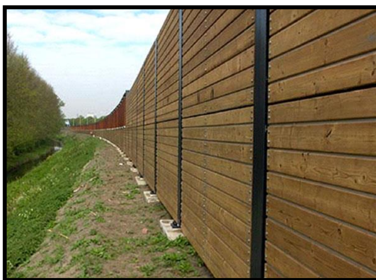
Εικόνα 25. Ξύλινη κατασκευή σε ηχοπέτασμα ( http://www.greekarchitects.gr/images/news/mantanis.2011.03.02.jpg )
