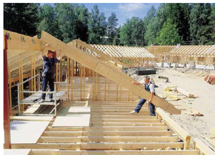
Εικόνα 2: Πλαίσια κατοικιών με πάτωμα L.V.L.
