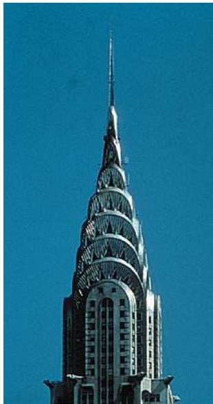
Κτίριο Chrysler -Νέαας Υόρκη
