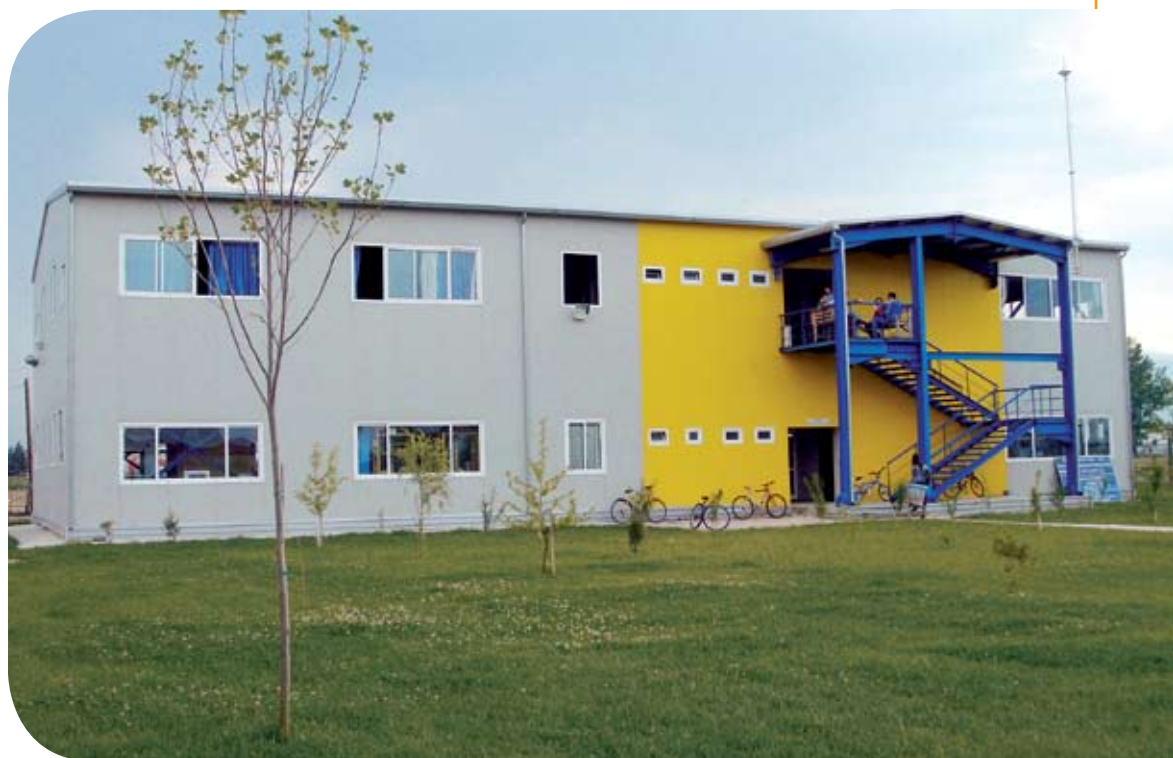
Το κτίριο των Εργαστηρίων του Τμήματος
