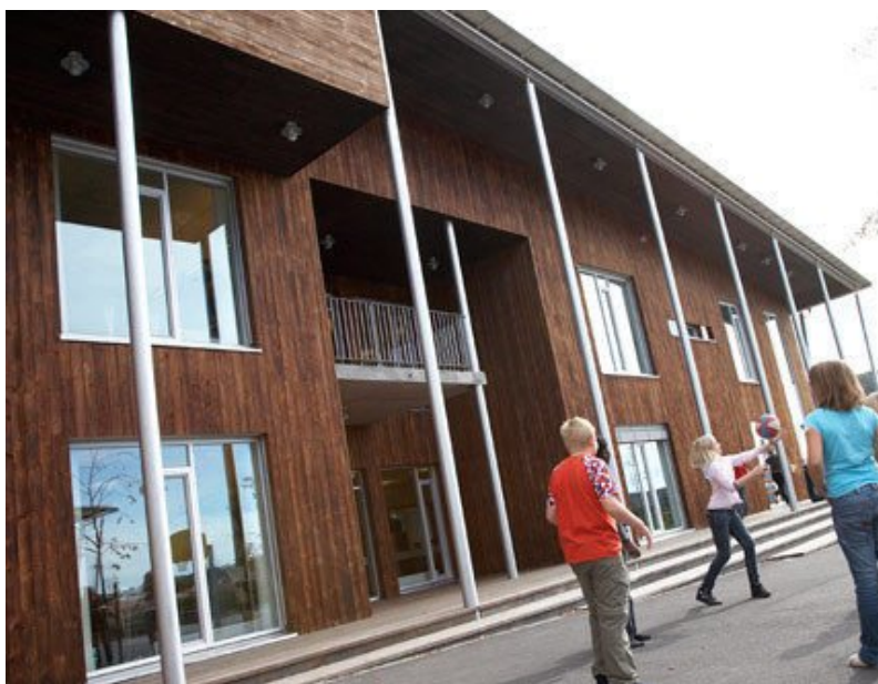
Εξωτερική ξύλινη επένδυση σε σχολείο
