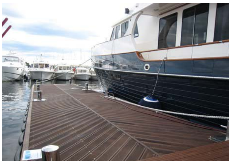
Δάπεδο τύπου decking σε προβλήτα
