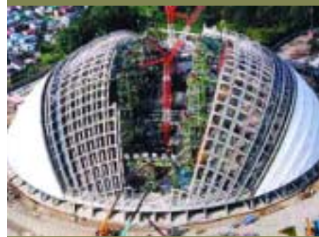
Κατασκευή σκελετού θόλου με φορμαρισμένο (καμπύλο) L.V.L. στην Ιαπωνία
