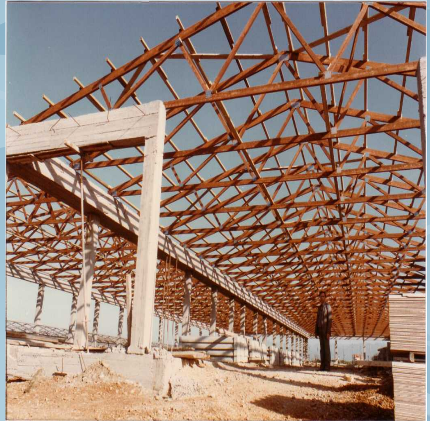
ΔΤΕΡΗ ΒΙΟΜΗΧΑΝΙΚΟΥ ΚΤΙΡΙΟΥ ΜΕ ΠΛΑΤΕΙΑ ΓΚΑΝ.
