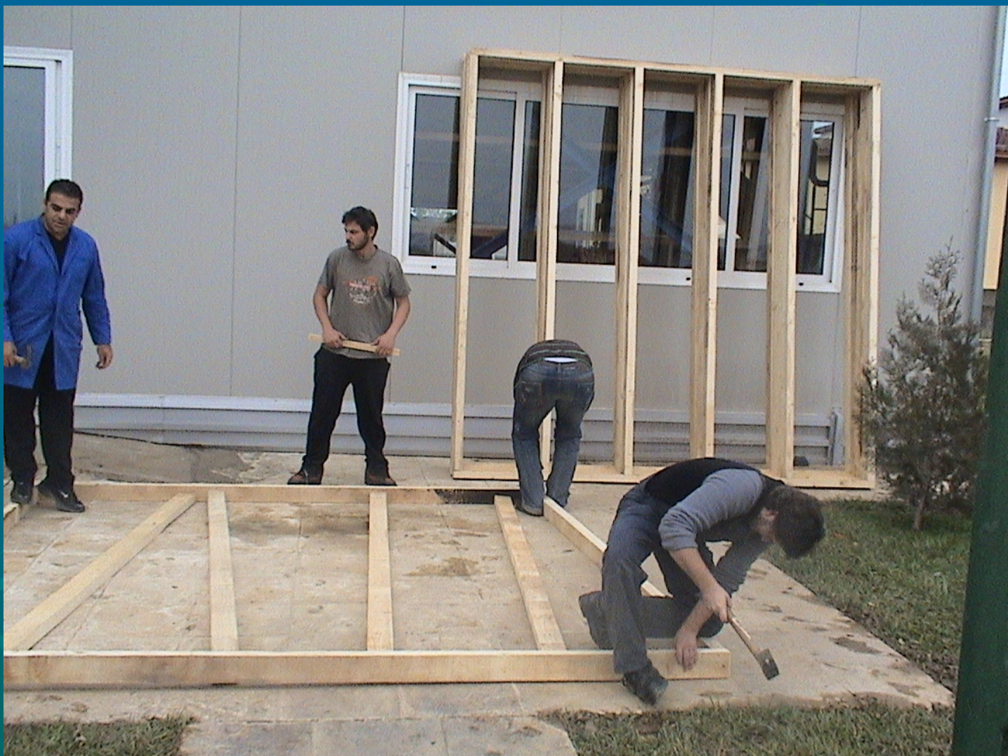
Προκατασκευή πλαισίων τοιχωμάτων
