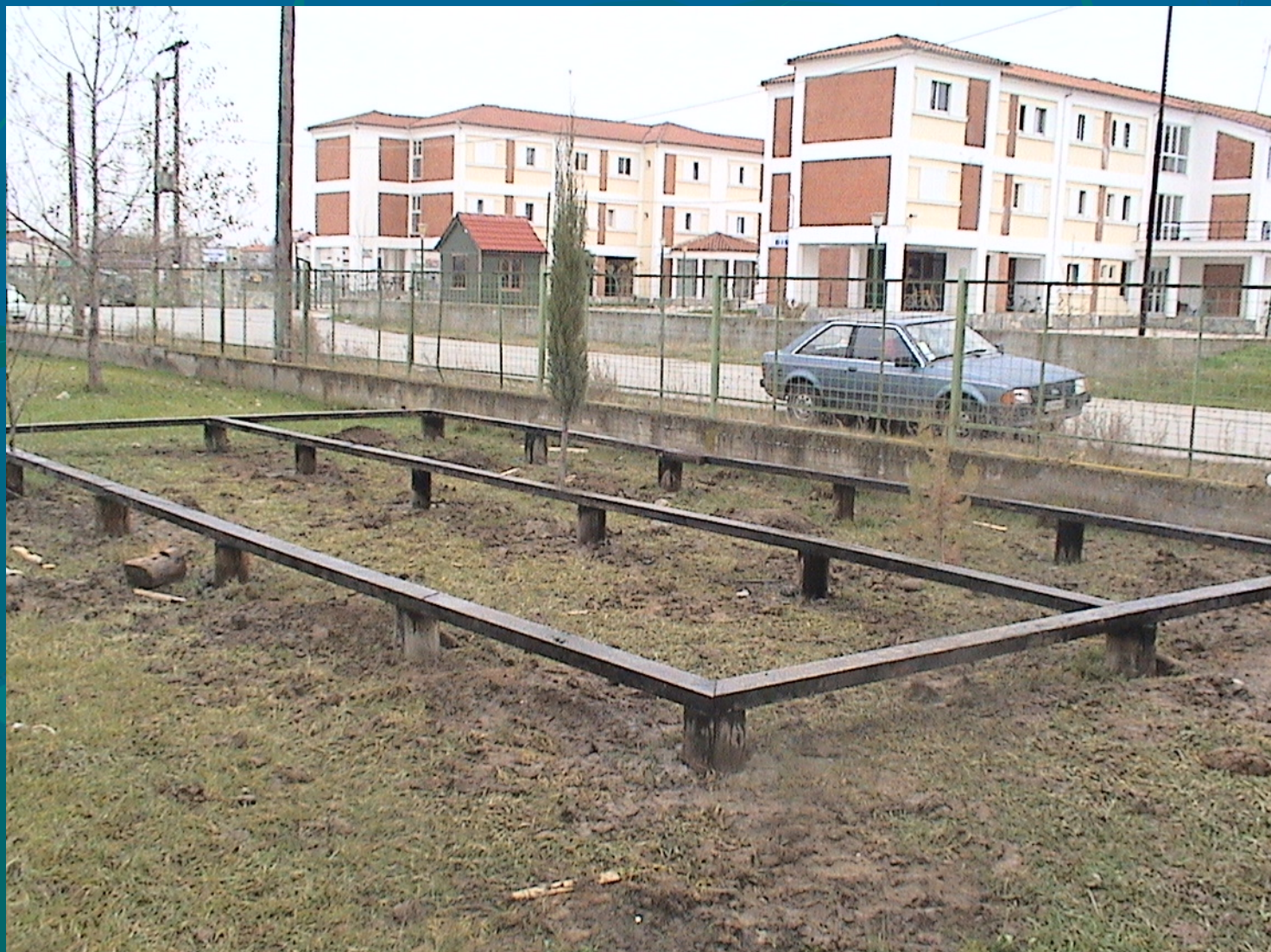
Θεμελίωση σπιτιού με πακτωμένους ξύλινους στύλους
