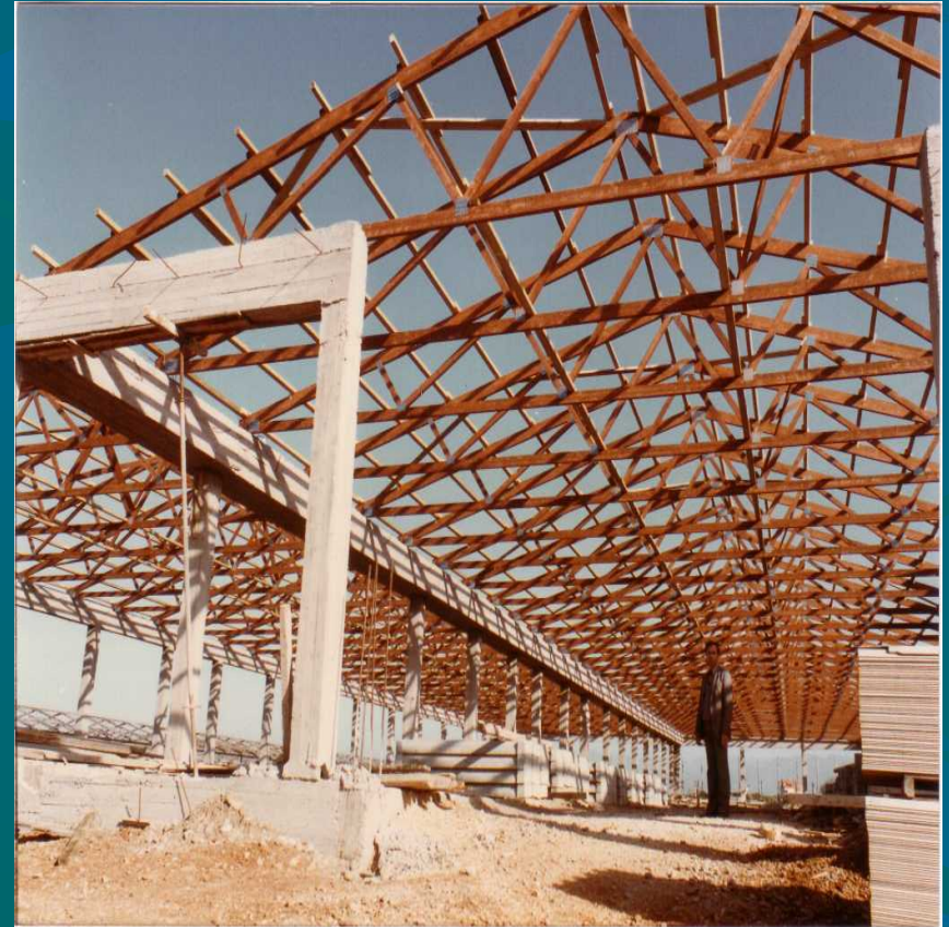
ΔΤΕΡΗ ΒΙΟΜΗΧΑΝΙΚΟΥ ΚΤΙΡΙΟΥ ΜΕ ΠΛΑΤΕΙΑ ΓΡΑΝ.
