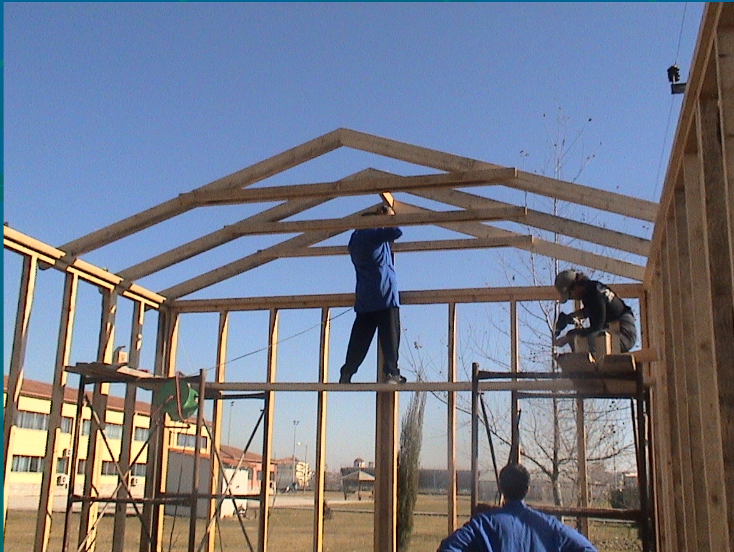
Τοποθέτηση προκατασκευασμένων ξευκτών στέγης
