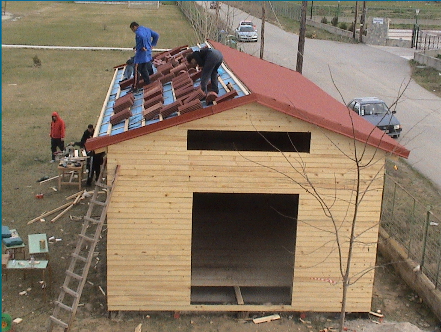
Τοποθέτηση κεραμιδιών στη στέγη
