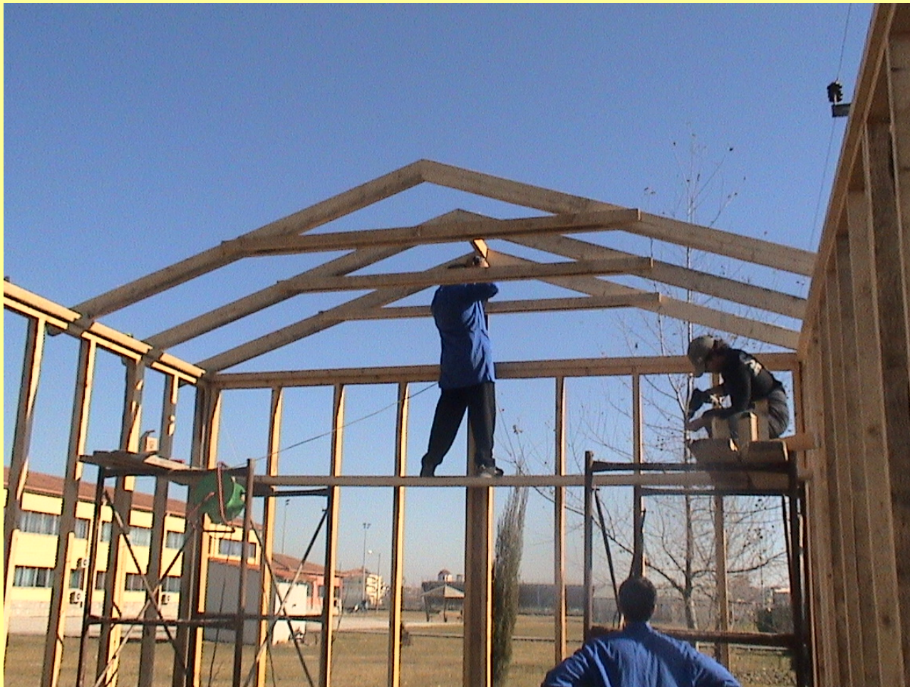
Erection of prefabricated roof elements Τοποθέτηση προκατασκευασμένων ζευκτών στέγης
