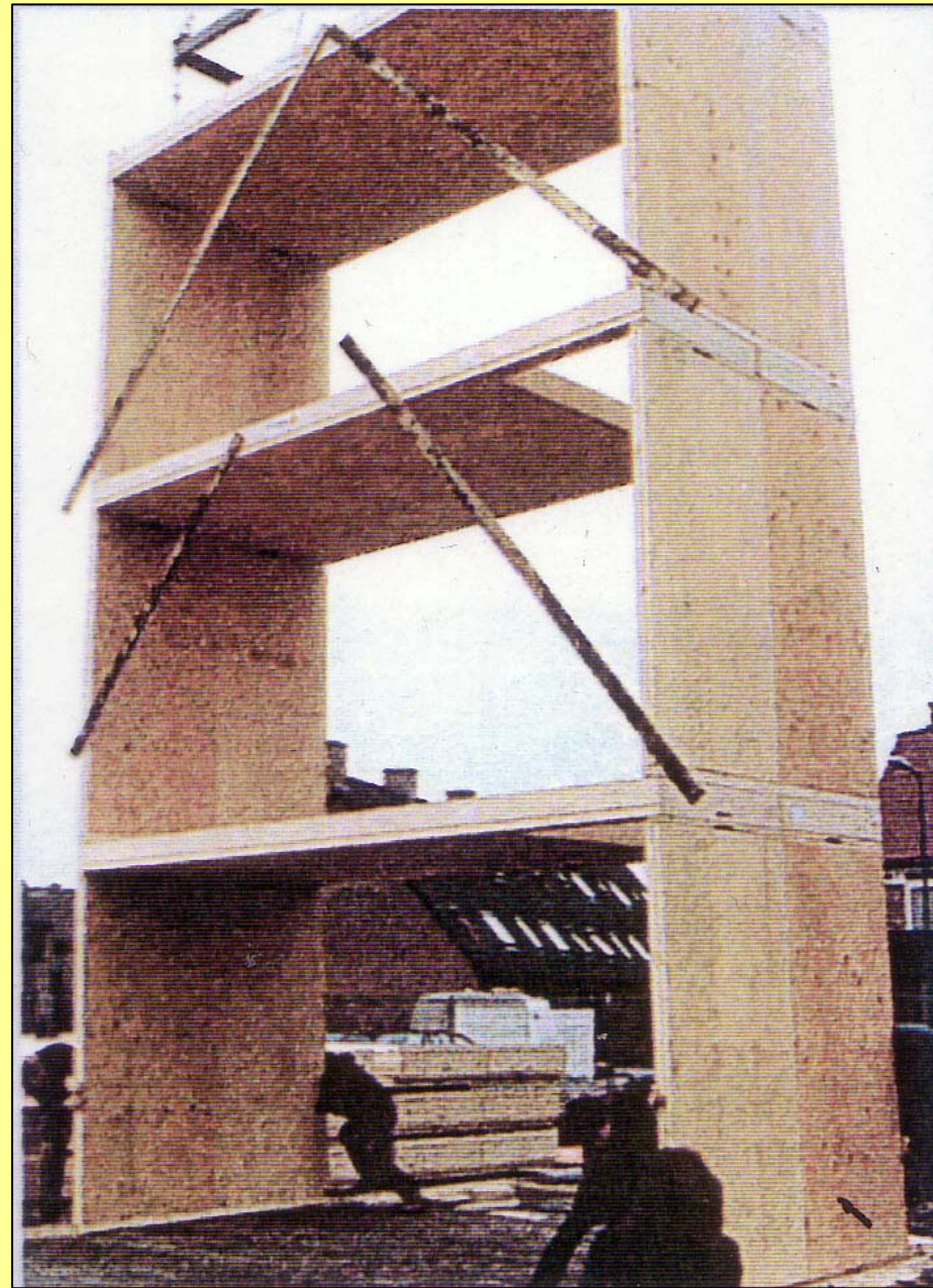
Erection of folded element timber house Εγκατάσταση κτιρίου με αναδιπλούμενα πλαίσια
