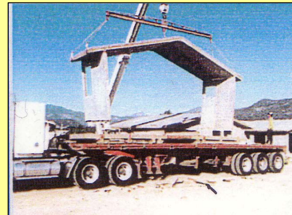
Transportation of folded element timber house Μεταφορά αναδιπλούμενων πλαισίων τύπου FOLDEX
