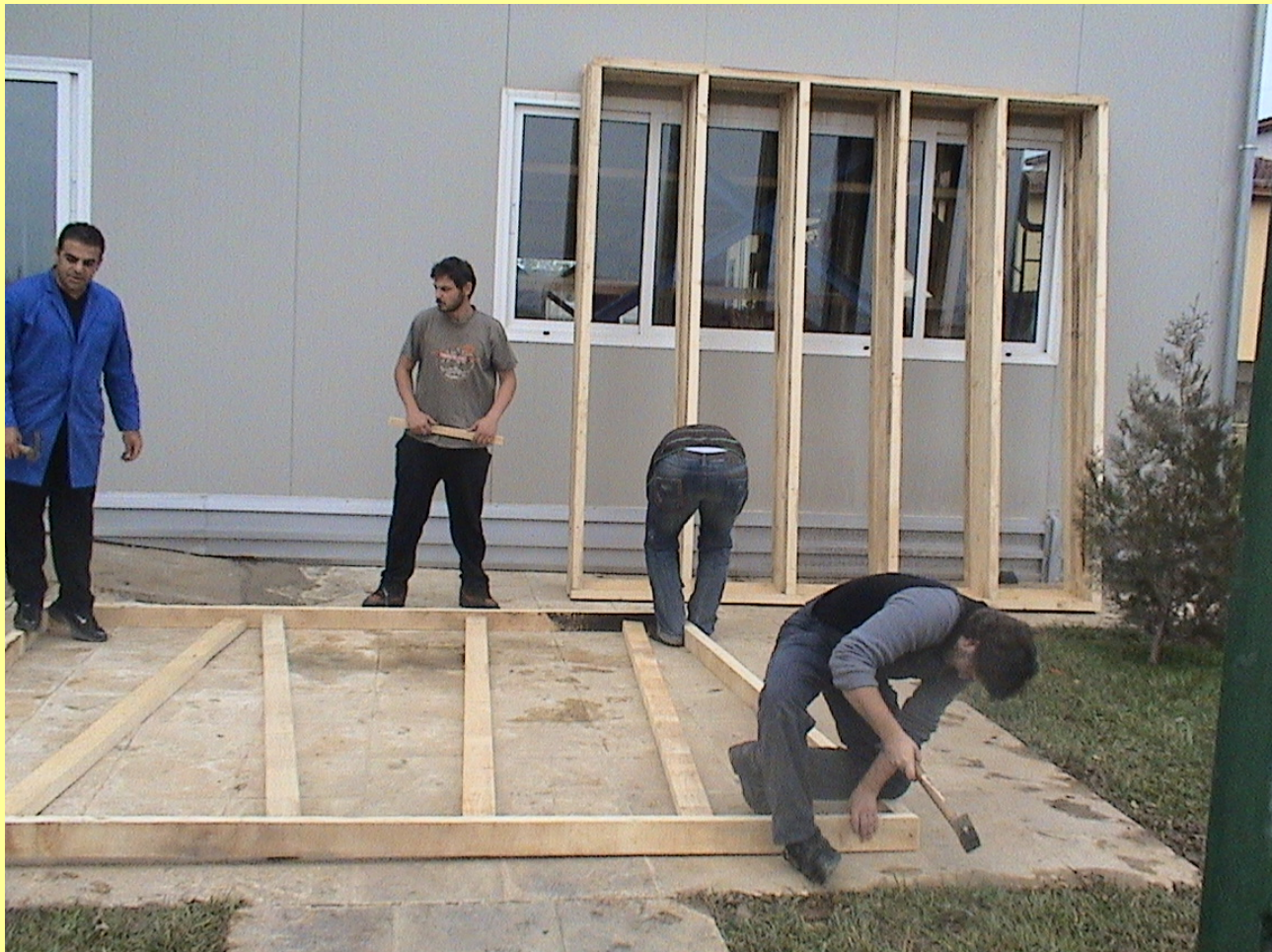
Prefabrication of timber frame wall elements Προκατασκευή πλαισίων τοιχωμάτων
