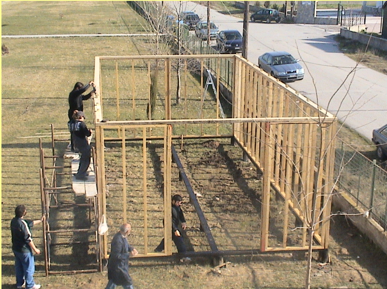
Fastening of timber frame skeleton on wood pole foundation Στερέωση πλαισίων σκελετού σε ξύλινους στρωτήρες
