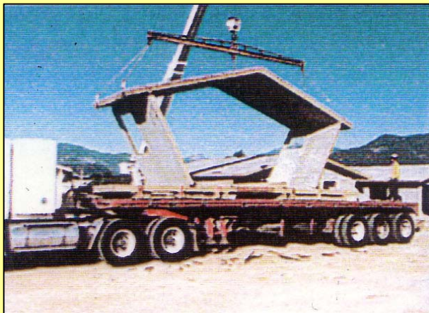
Transportation of folded element timber house Μεταφορά αναδιπλούμενων πλαισίων τύπου FOLDEX
