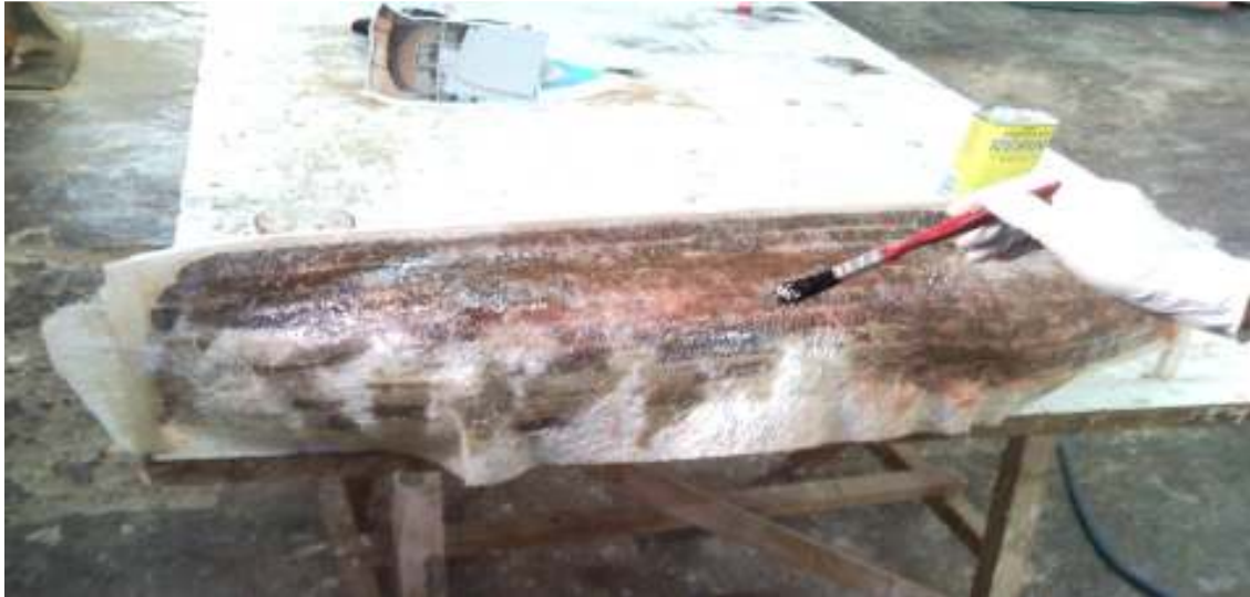
Εικ.61 Διαδικασία τοποθέτησης του fiberglass.
