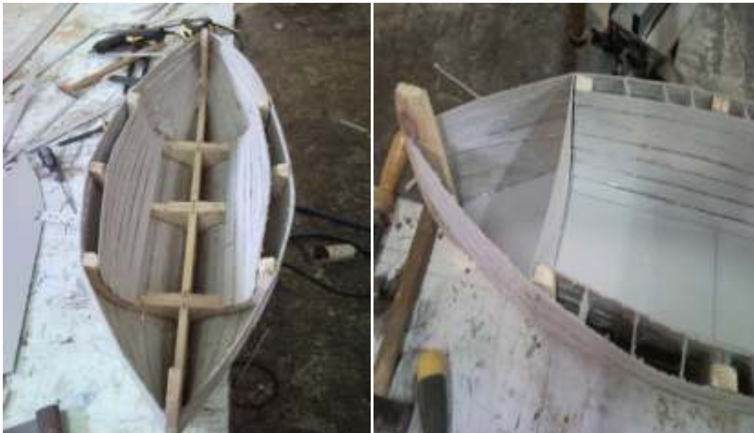
Εικ.58 - 59 Διαδικασία στερέωσης του εξωτερικού περιβλήματος.
