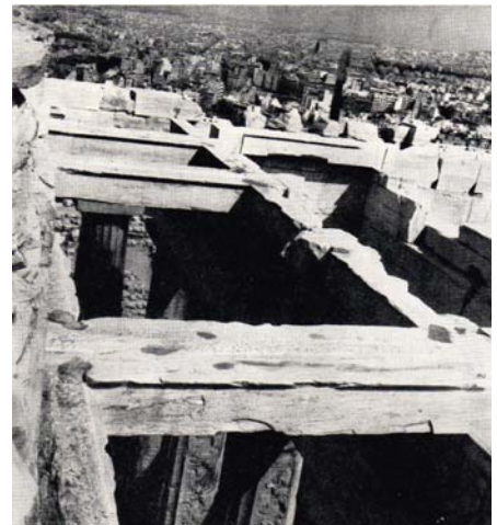
Εικ. 3.3.7 Παρούσα κατάσταση των δοκών της οροφής της δυτικής στενής πλευράς του περού αριστερά και του οπισθοναού δεξιά.
