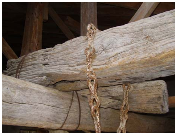
Εικόνα 6 Ι.Μ. Αγίας Τριάδος-Φθαρμένα δοκάρια στέγης
