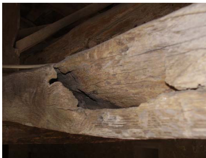
Εικόνα 37. Ι.Μ. Βαρλαάμ-Έντονα αποσαθρωμένο δοκάρι στέγης χαγιατιού
