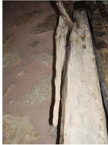
Εικόνα 49. Ι.Μ. Ρουσάνου-Σχίσμο των ινών του ξύλου τμήματος της παλιάς πόρτας, εξ' αιτίας μεταλλικού συνδέσμου
