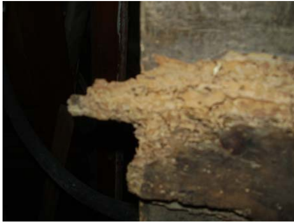
Εικόνα 33. Ι.Μ. Βαρλαάμ-Έντονα αποσαθρωμένο και προσβεβλημένο από έντομα τμήμα πόρτας της αποθήκης
