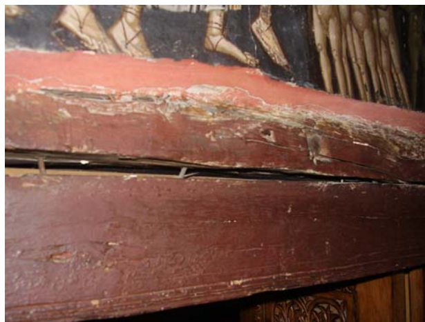
Εικόνα 54. Ι.Μ. Ρουσάνου-Μεγάλη ραγάδα σε δοκάρι της πόρτας του κυρίως ναού του καθολικού της μονής
