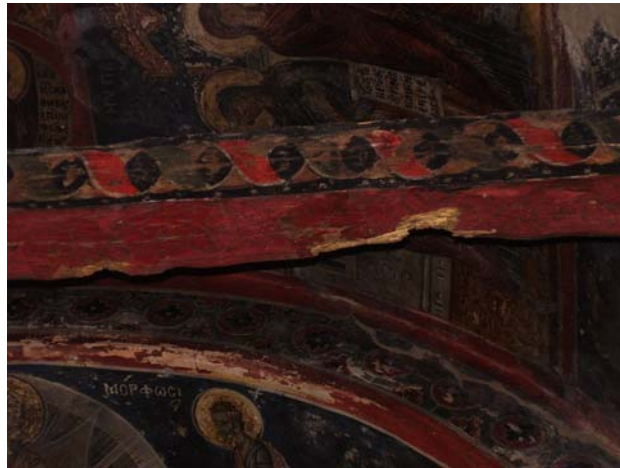
Εικόνα 53. Ι.Μ. Ρουσάνου-Αποπίπτοντα τμήματα ξύλου σε ξυλοδεσιά
