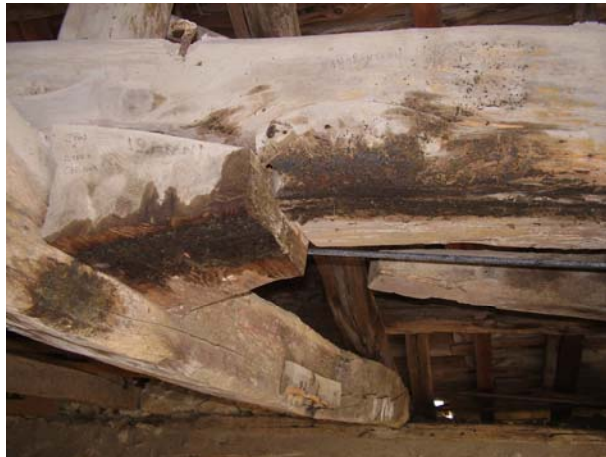
Εικόνα 38. Ι.Μ. Βαρλαάμ-Μόνο μερικά παλιά ξύλινα δοκάρια έχουν παραμείνει στη θέση τους, τα υπόλοιπα έχουν αντικατασταθεί από νέα
