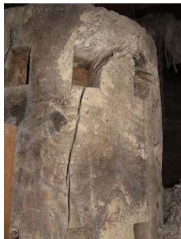
Εικόνα 29. Ι.Μ. Μ. Μετεώρου-Τμήμα του ξύλινου εργάτη, διακρίνονται ραγαδώσεις και προσβολή από έντομα
