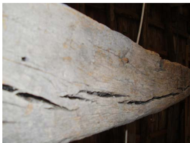
Εικόνα 40. Ι.Μ. Βαρλαάμ-Μεγάλου μήκους ρωγμές σε δοκάρι
