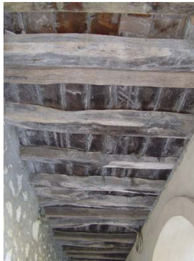
Εικόνα 2 Ι.Μ. Αγίας Τριάδος-Δοκάρια και τάβλες του πατώματος παλιού μπαλκονιού
