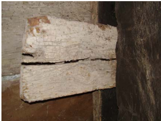
Εικόνα 19. Ι.Μ. Μ. Μετεώρου-Έντονη προσβολή από έντομα και μεγάλη ραγάδα κατά μήκος των ιών
