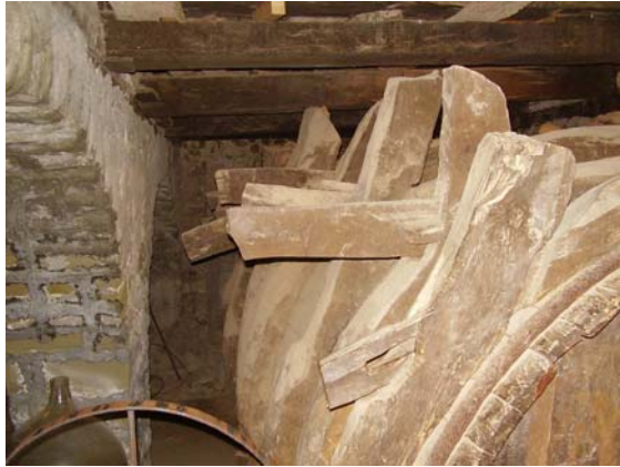
Εικόνα 18. Ι.Μ. Μ. Μετεώρου-Έντονο σκέβρωμα λόγω μεγάλου μήκους των δοκαριών
