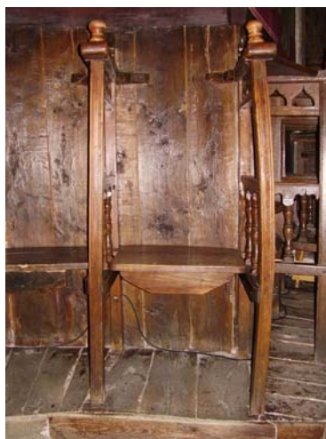
Εικόνα 67 Ι.Μ. Αγίου Στεφάνου-Στασίδι, σκέβρωμα
