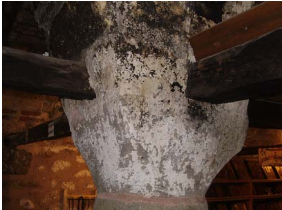
Εικόνα 30. Ι.Μ. Βαρλαάμ-Ξυλοδεσιές στο χώρο του παλιού γηροκομείου
