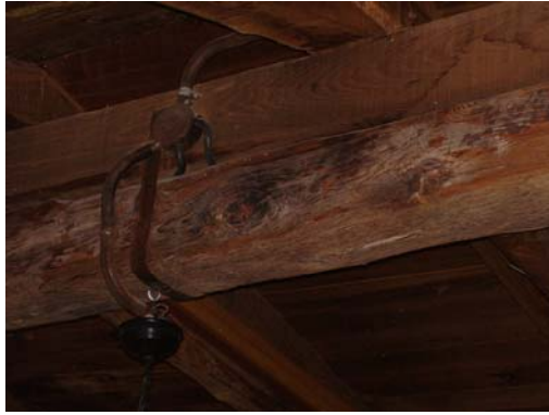
Εικόνα 46. Ι.Μ. Ρουσάνου-Η παλιά ξυλοδεσιά στηρίχτηκε με νέα
