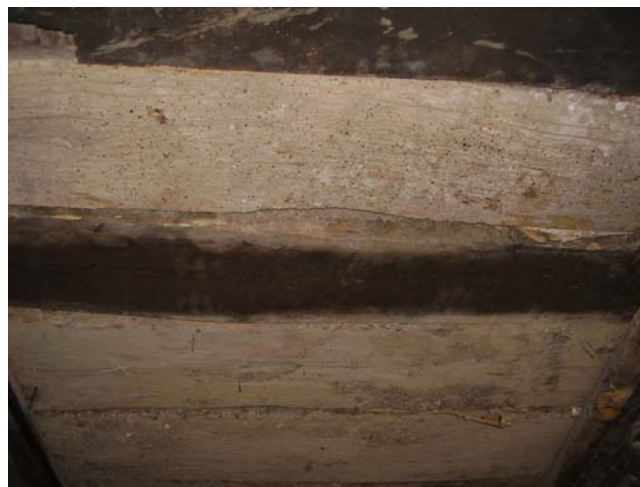
Εικόνα 17. Ι.Μ. Μ. Μετεώρου-Έντονη προσβολή από έντομα σε τάβλες του ταβανιού στο κελάρι
