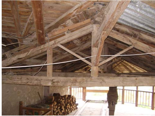
Εικόνα 35. Ι.Μ. Βαρλαάμ-Ξύλινη στέγη χαγιατιού
