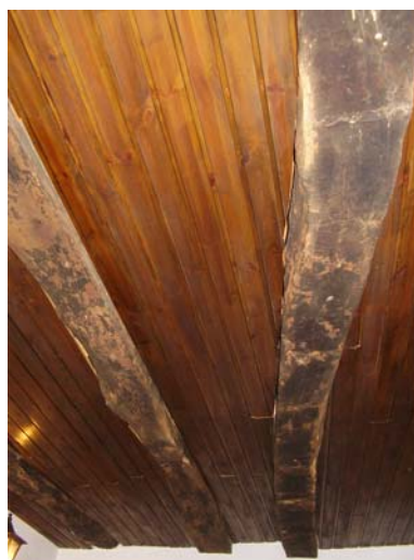
Εικόνα 51. Ι.Μ. Ρουσάνου-Σκέβρωμα των δοκαριών εξ' αιτίας του πολύ μεγάλου μήκους τους
