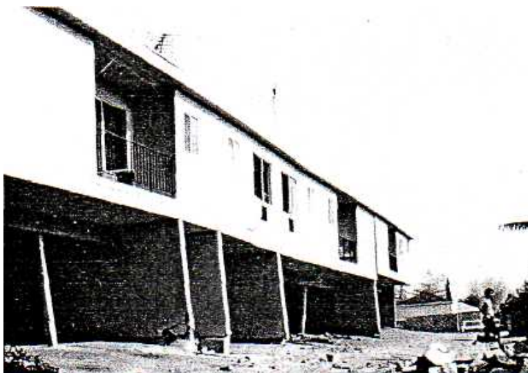
Εικ. 48. Κατοικία με σοβαρή ατέλεια αδύνατης κατασκευής ισογείου (San Fernando Earthquake, 1971)
