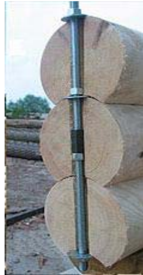
Εικ. 25. Κορμοί που συνδέονται με σιδερένιους πείρους (ντίζες).
