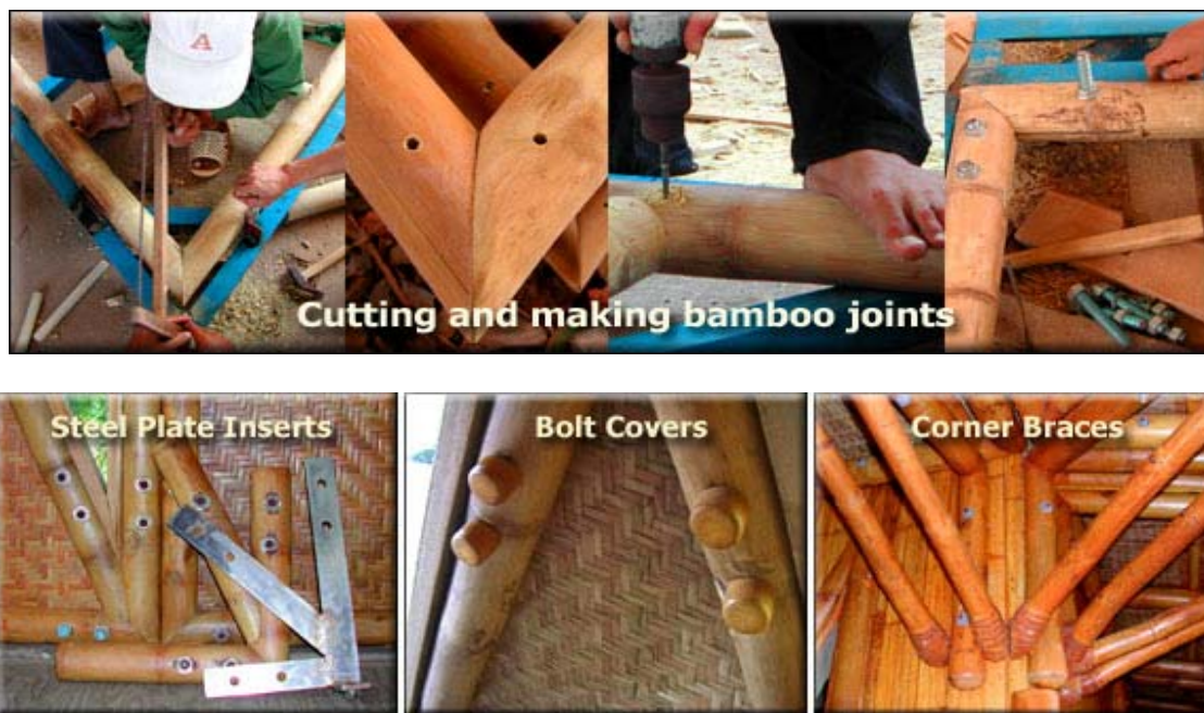
Εικ. 38. Συνδέσεις με ενισχυμένες χαλύβδινες πλάκες και μπουλόνια.
