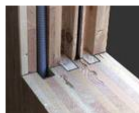
Εικ. 42 α,β: σύνδεση στοιχείων τοιχοποιίας με ξένο μόρσο, γ,δ: στοιχεία τοιχοποιίας.
