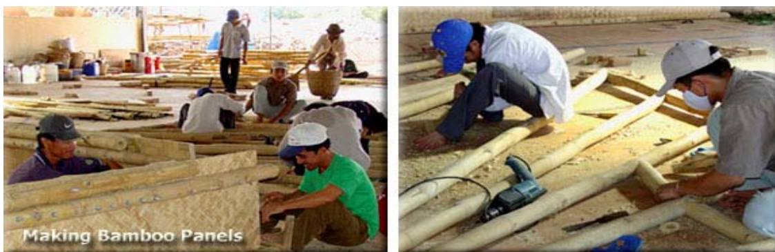
Εικ. 36. Κατασκευή των πάνελς.
