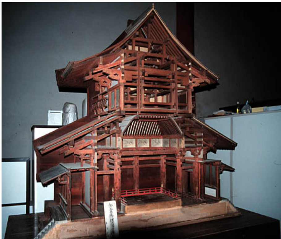
Εικ. 50. Μακέτα του ναού που δείχνει την κατασκευή του ξύλινου σκελετού.
