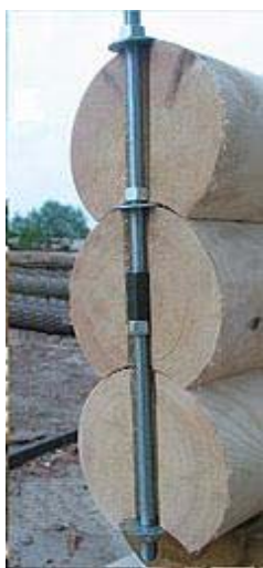
Εικ. 31. Σύνδεση με ανοξειδωτες μεταλλικές ράβδους.
