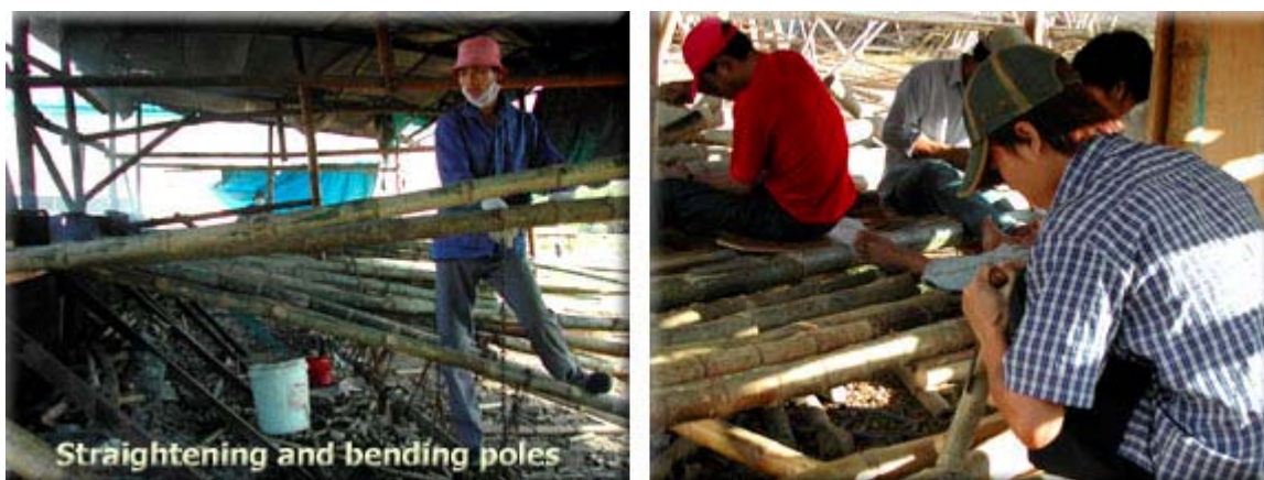
Εικ. 37 α) Ταξινόμηση και καθαρισμός των κορμιδίων (στύλων) μπαμπού.
