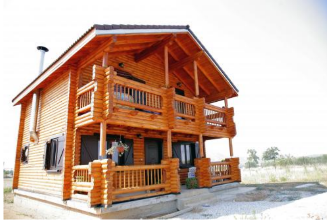
Κατασκευή πρότυπης κατοικίας.
