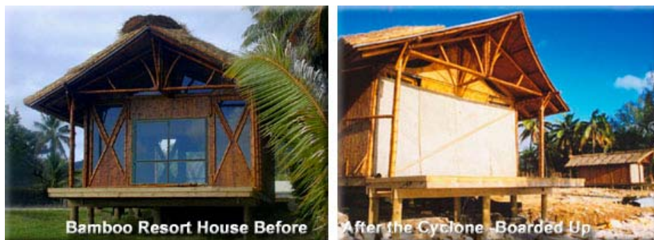
Εικ. 52. Κατοικία από μπαμπού σε τουριστικό θέρετρο πριν και μετά τον τυφώνα Olaf 2005. Η ζημία περιορίστηκε στην θραύση των κρυστάλλων.
