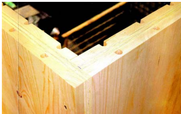
Εικ. 12. Ολόσωμο πάνελ τοιχοποιίας 3 ή 5 στρώσεων με αντικολλητή διάταξη των στρώσεων.
