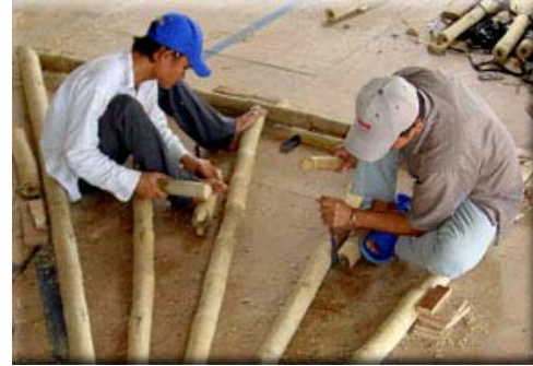
Εικ. 7. α) Στύλοι μπαμπού μετά την υλοτομία, β) εφαρμογή σε πλαίσια σκελετού κατοικίας.
