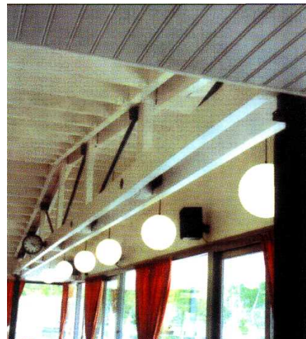
Εικ. 5. Εφαρμογή του Lignostone στην ενίσχυση συνδέσεων ζευκτών στέγης μεγάλων ανοιγμάτων.
