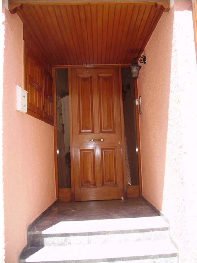
11. Κεντρική ταμπλαδοτή πόρτα εισόδου πολυκατοικίας με σταθερά σημεία από τζάμι ασφαλείας.
