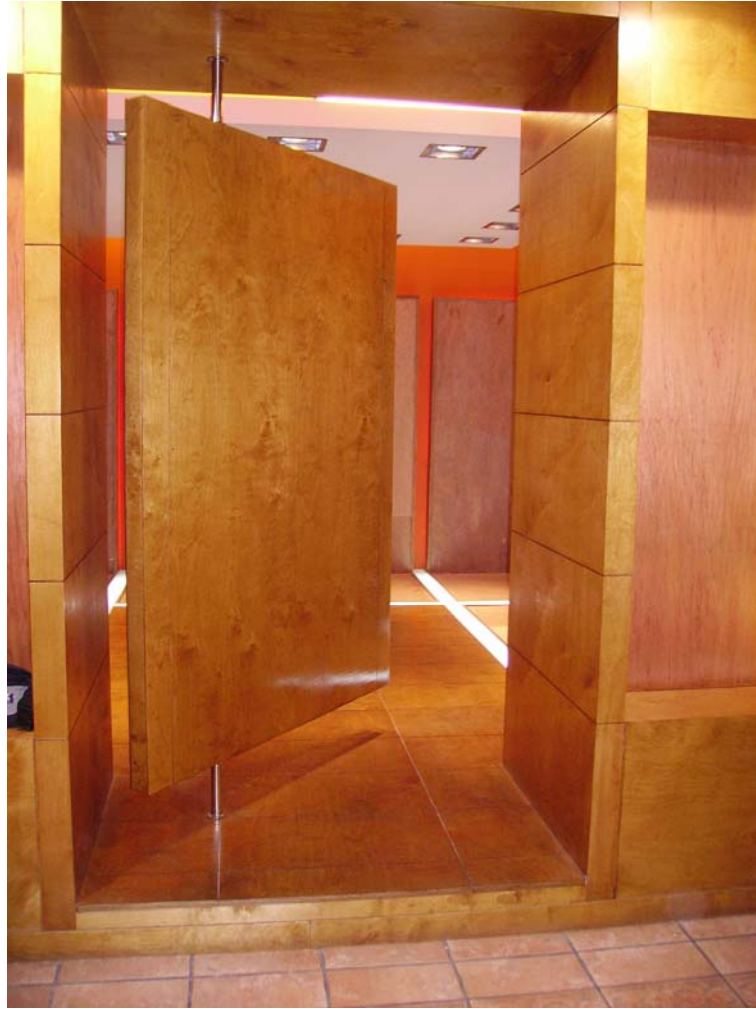
10.2. Λεπτομέρειες ανοιγόμενης πόρτας σε μεταλλικό σωλήνα.
