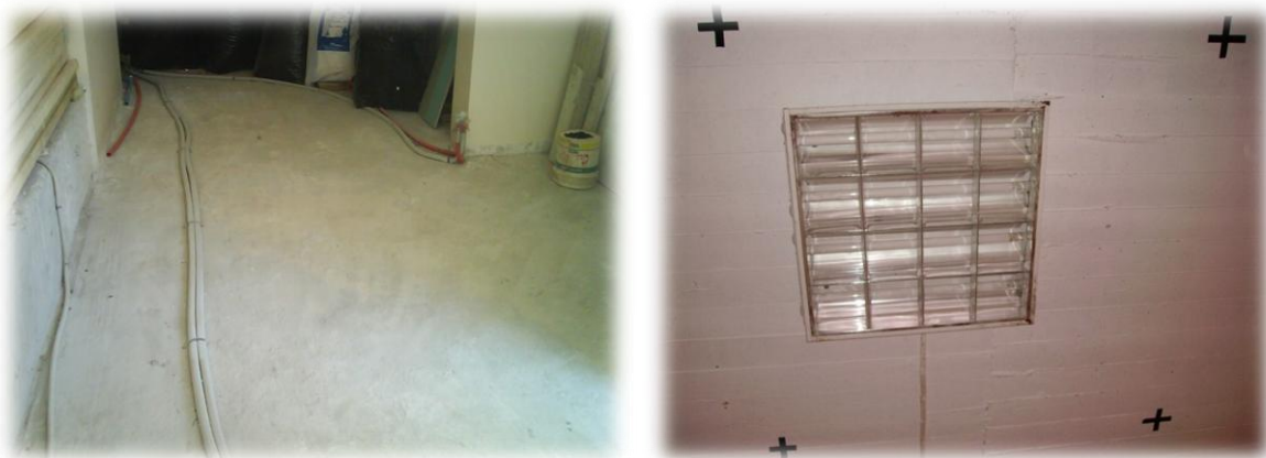
Εικόνα 45. Όψη του πειραματικού χώρου, πριν την κατασκευή των δειγμάτων (ισόγειο – υπόγειο).
