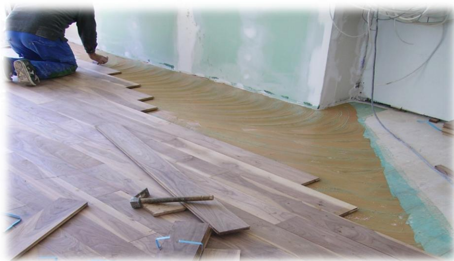
Εικόνα 25. Τοποθέτηση κολλητού δαπέδου.
