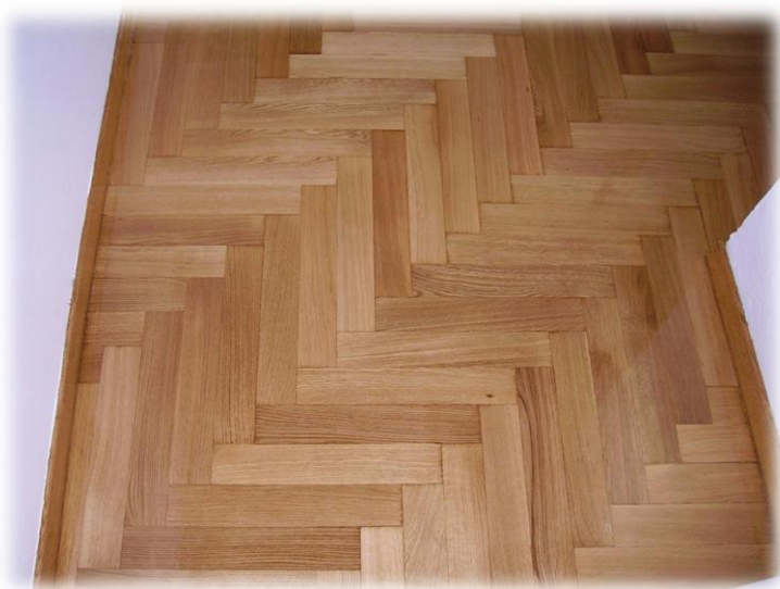
Εικόνα 23. Τοποθετημένα παρκέτα σε κάθετη διάταξη («ψαροκόκκαλο»)
