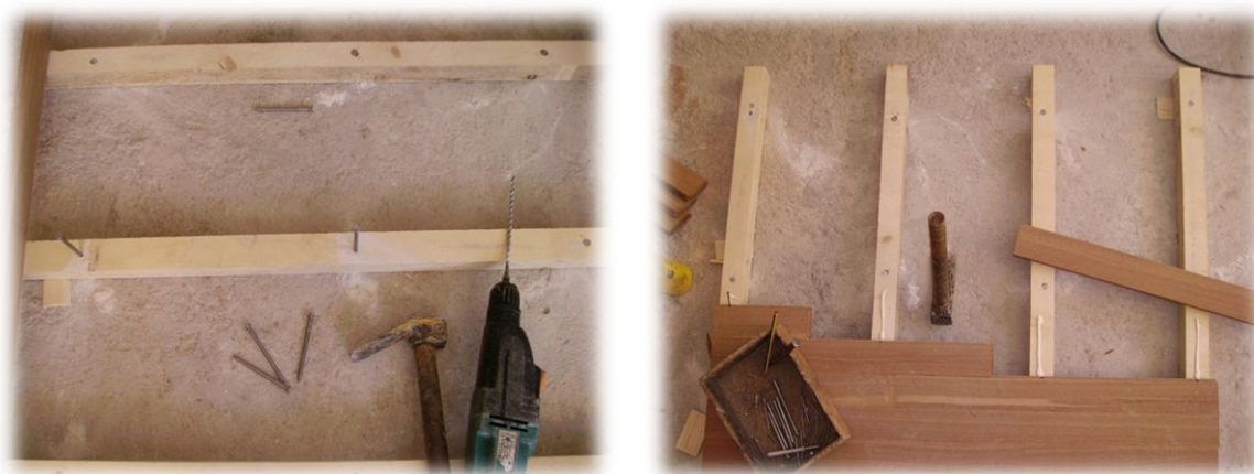
Εικόνα 40. Κατασκευή καρφωτού δείγματος απλής μορφής.
