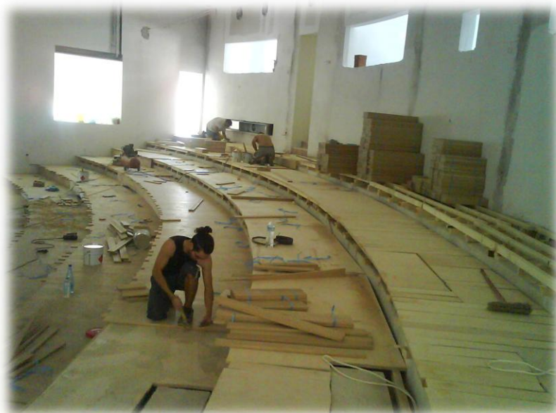
Εικόνα 24. Τοποθέτηση καρφωτού δαπέδου. 18
