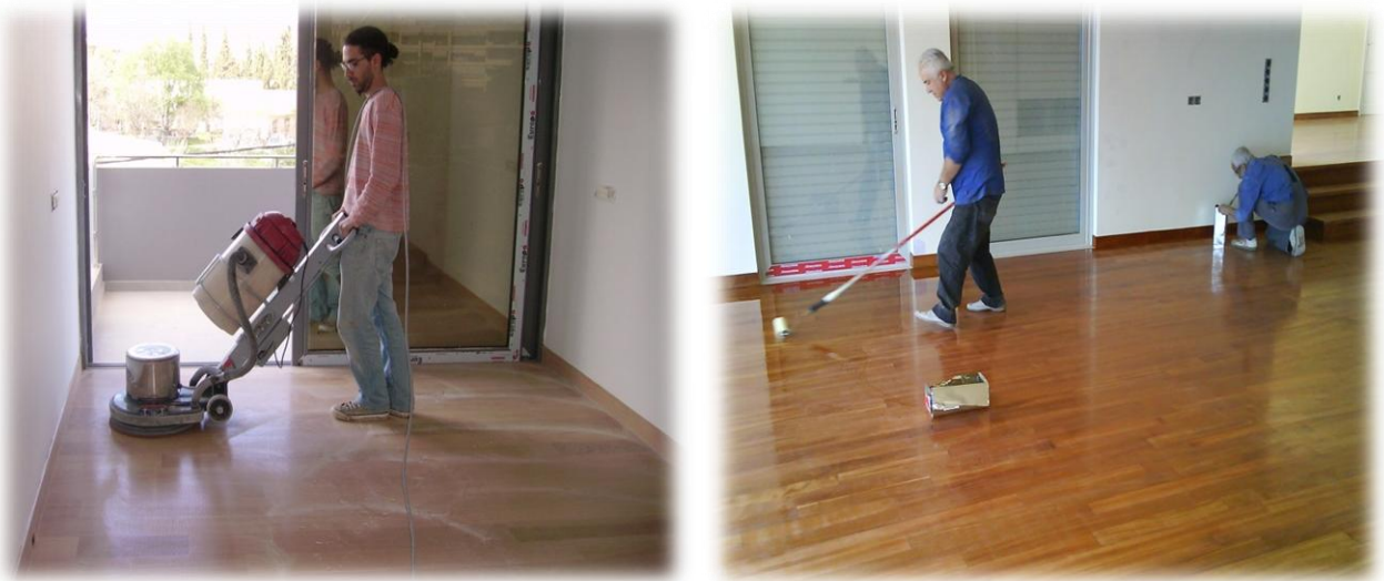
Εικόνα 28. Λείανση πρώτης στρώσης βερνικιού, και εφαρμογή στρώσης. 18
