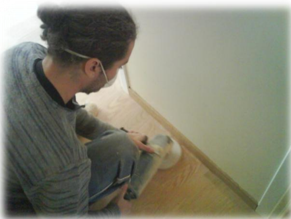
Εικόνα 27. Διαδικασία λείανσης με κατάλληλες μηχανές και γυαλόχαρτα. 18
