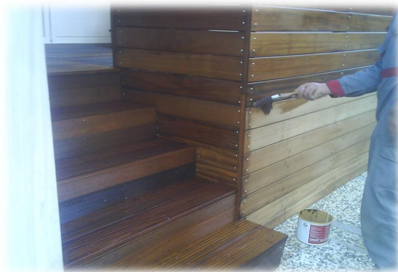
Εικόνα 29. Τελείωμα παρκέτων εξωτερικού χώρου με λάδι.
